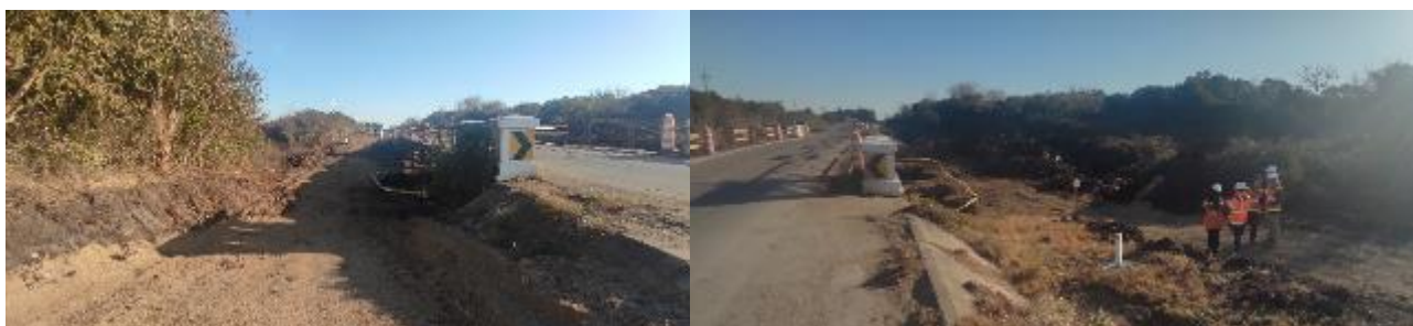
Foto 13.6-1 Puente Río Santa Lucía Paso Viejo
