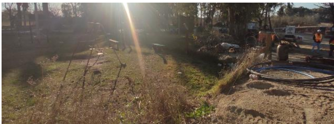
Foto 13.1-1 Perímetro divisorio roto.
