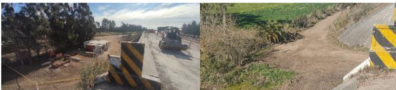
Foto 13.4-2 Pasaje Superior Vía Férrea en Tramo 613
