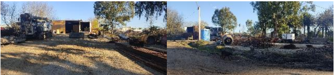
Foto 13.7-2 Obrador Puente Río Santa Lucía
