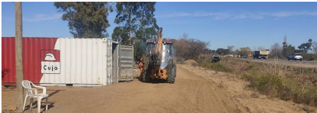
Foto 13.5-2 Inicio instalaciones de Obrador
