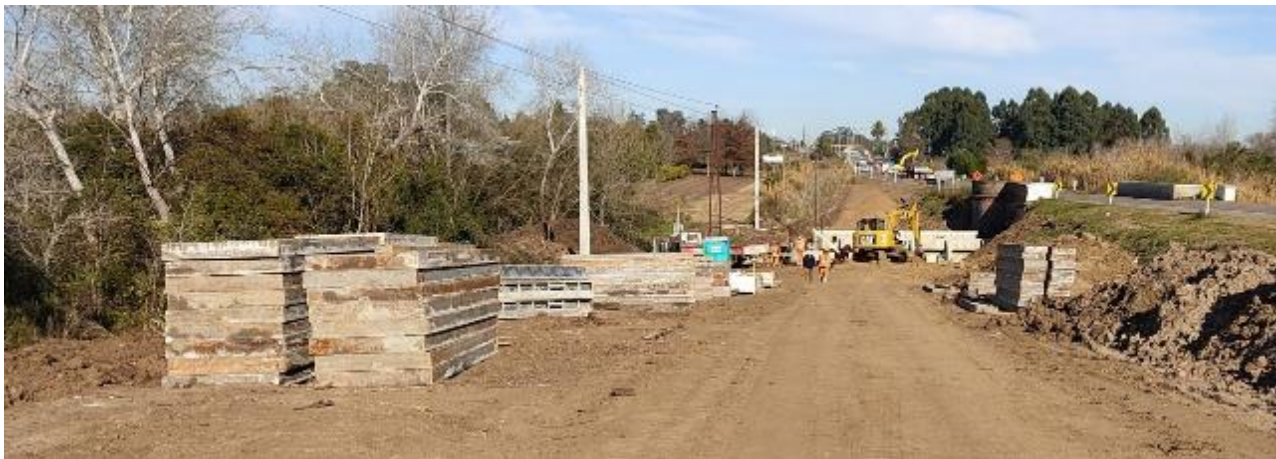
Foto 13.2-2 Zona de acopios frente de obra
