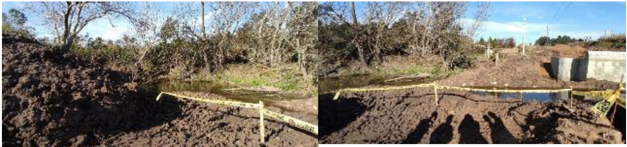
Foto 13.2-1 Vistas Frente de Obra
