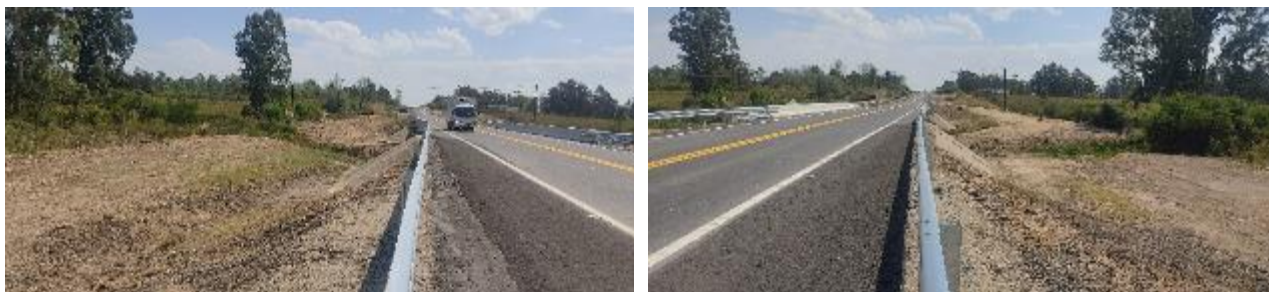
Foto 13.6-1 Entorno Puente Arroyo Matasiete.
