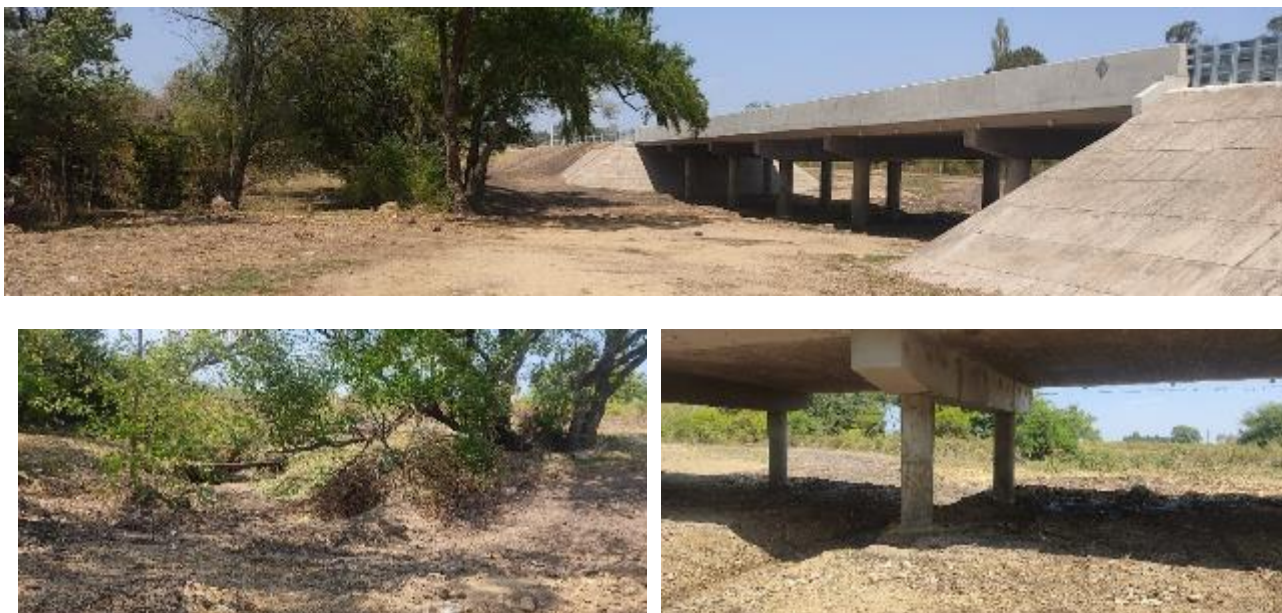
Foto 13.5-1 Entorno Puente Arroyo Vizcaíno.
