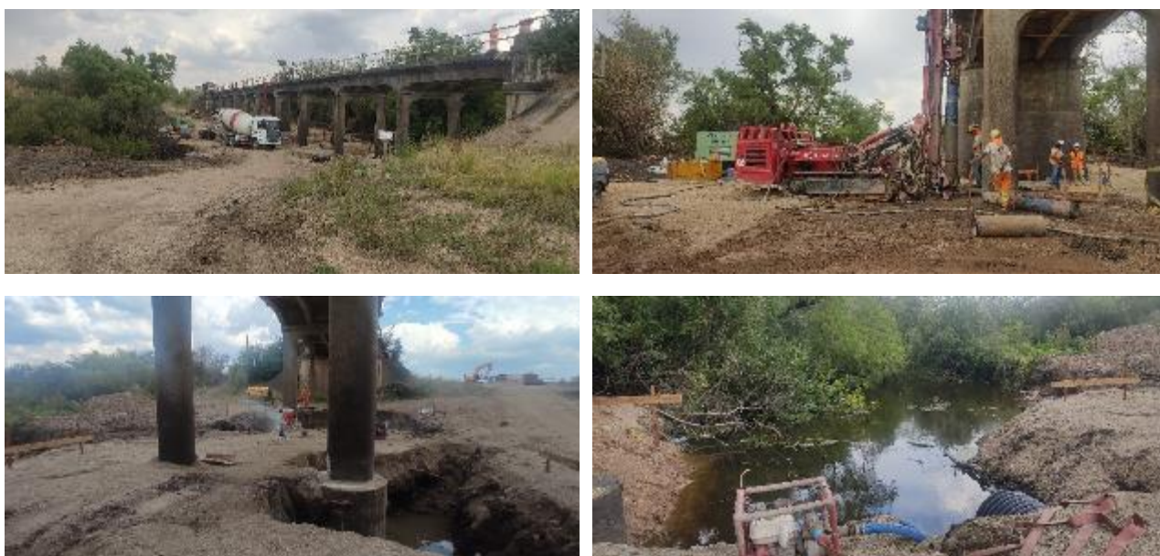
Foto 13.12-1 Entorno de obra Puente Arroyo Chamizo.
