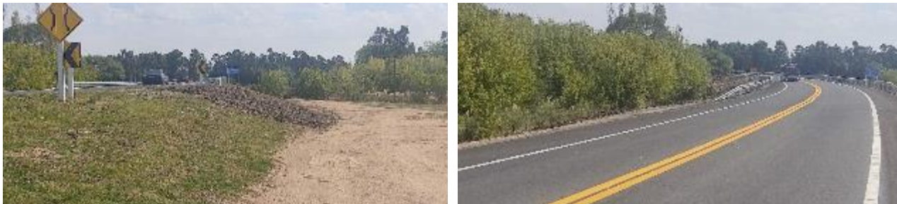
Foto 13.3-1 Entorno Puente Arroyo Colorado.
