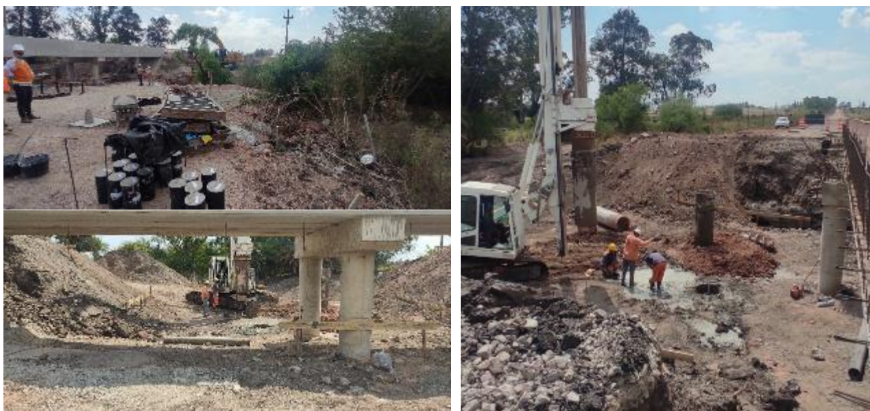
Foto 13.7-1 Vista entorno de obra Puente Arroyo Canelón Grande.
