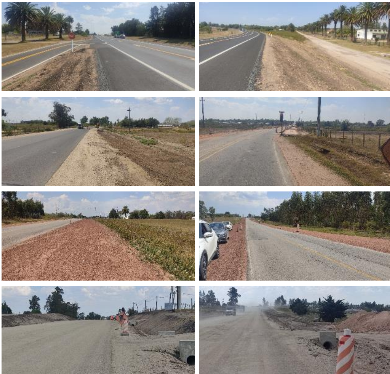
Foto 13.3-1 Vistas del tramo del contrato.
