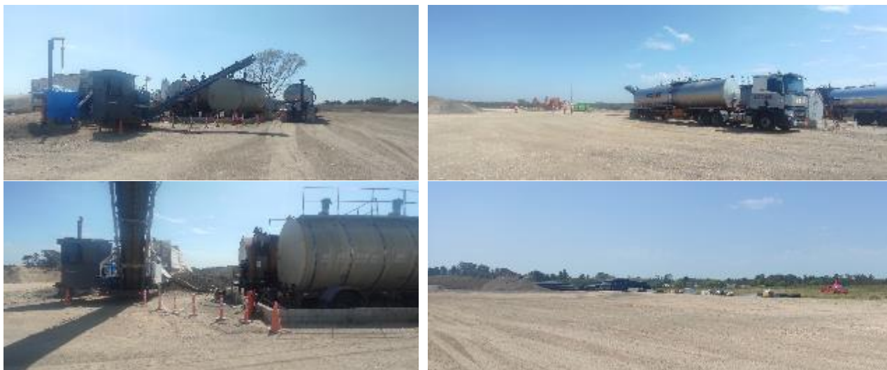
Foto 13.2-1 Obrador Grupo Cuchilla Grande.
