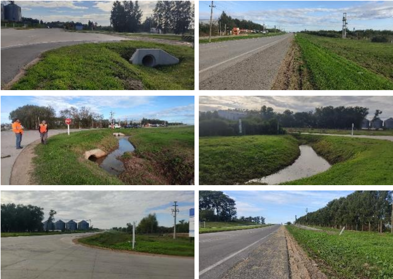
Foto 13.4-1 Vistas Bypass Nueva Palmira.
