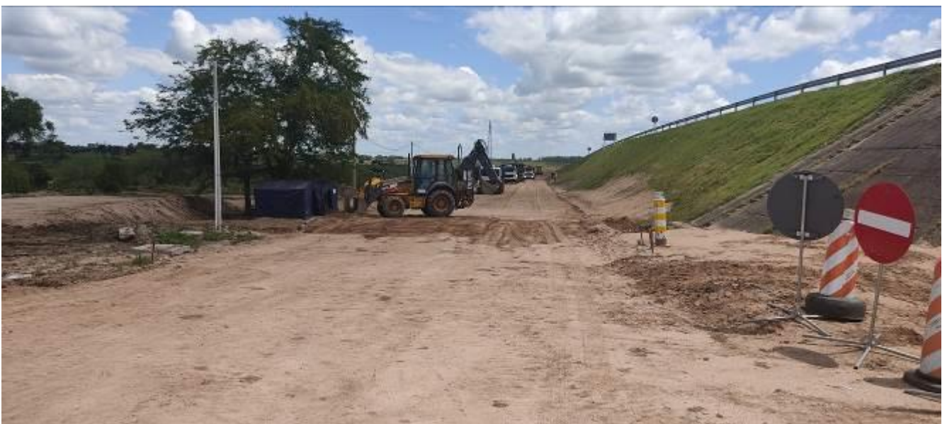
Foto 13.1-2 Campamento - Construcción del desvío.
