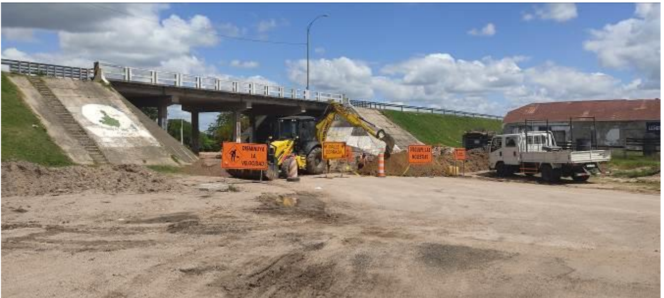
Foto 13.1-1 Entorno de obra
