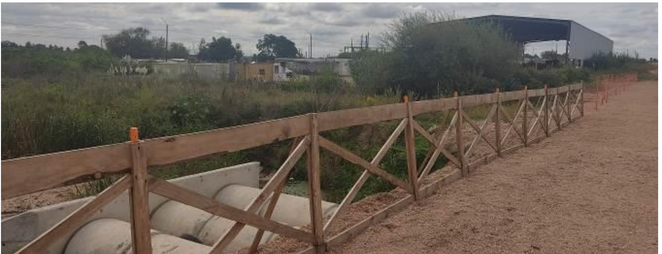
Foto 13.3-1 Obrador subcontrato FERRALIA
