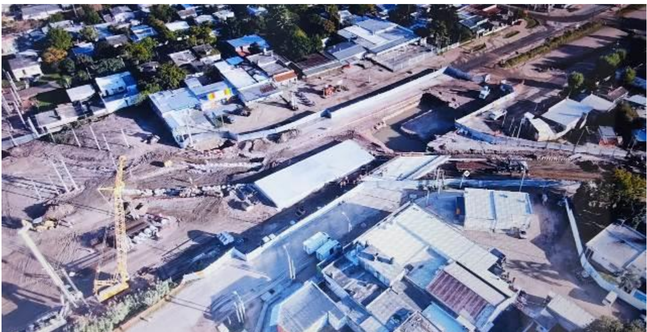
Foto 13.4-1 Vista aérea del entorno de obra.
