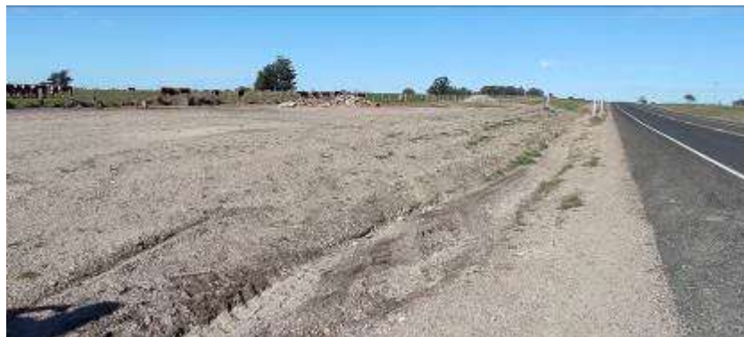
Foto 13.1-2 Acopios próximos Puente Arroyo Cerro de Ojosmin.
