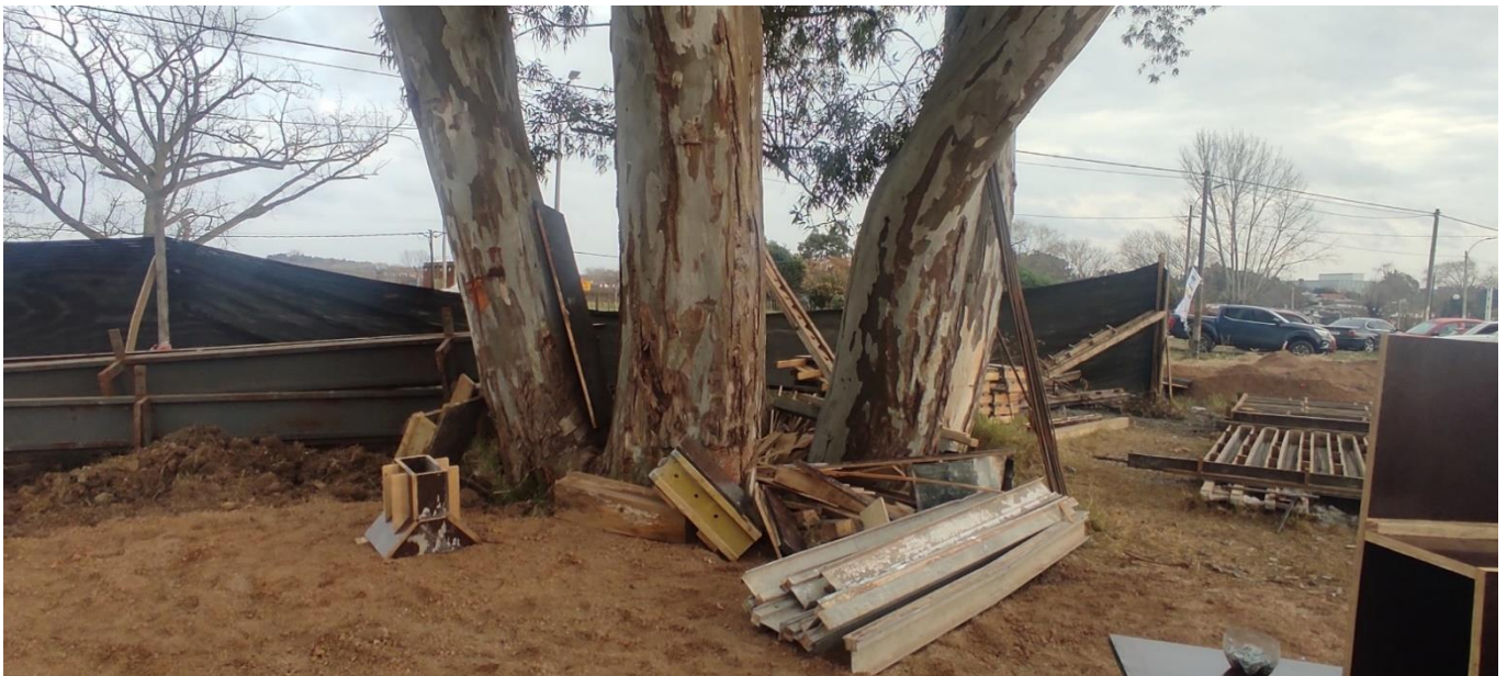
Foto 13.1-1 Estructuras y materiales apoyados y sujetos a vegetación existente.
