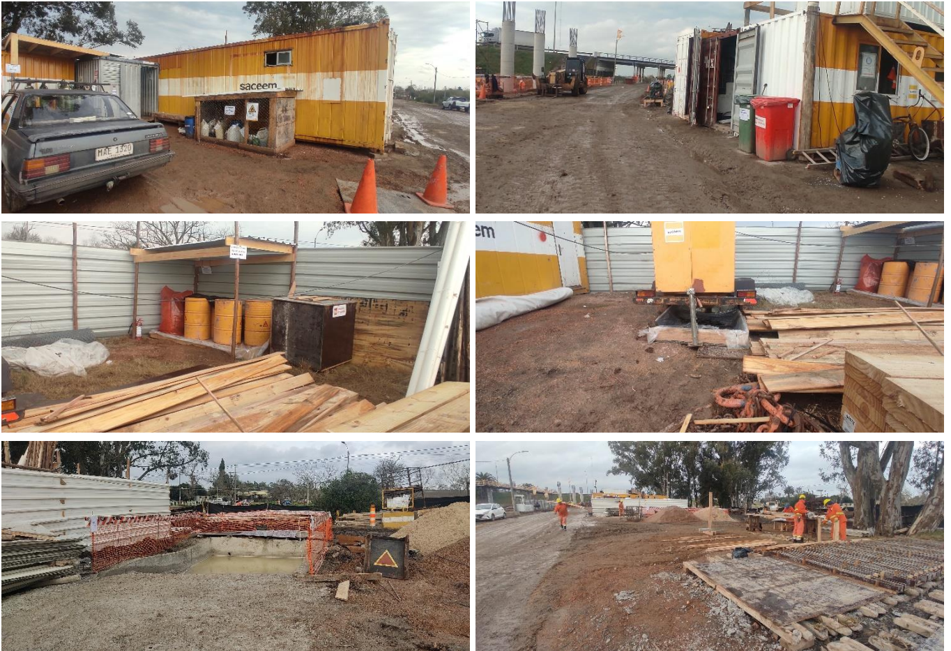
Foto 13.2-1 Vistas Obrador SACEEM
