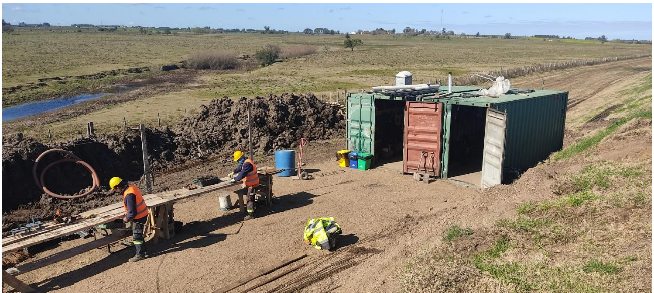
Foto 13.1-7 Vista 6 - Campamento subcontrato.
