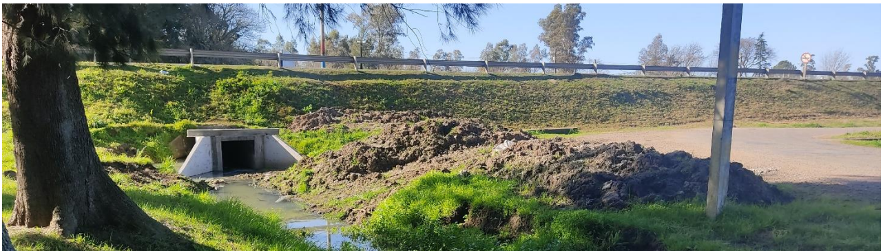
Foto 13.1-1 Vista 1 Alcantarilla terminada.
