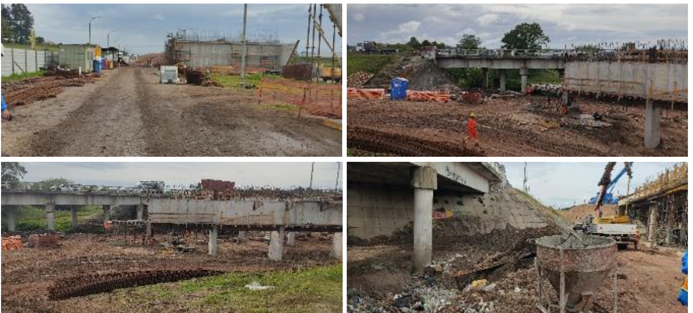
Foto 13.3-1 Vistas del Frente de Obra
