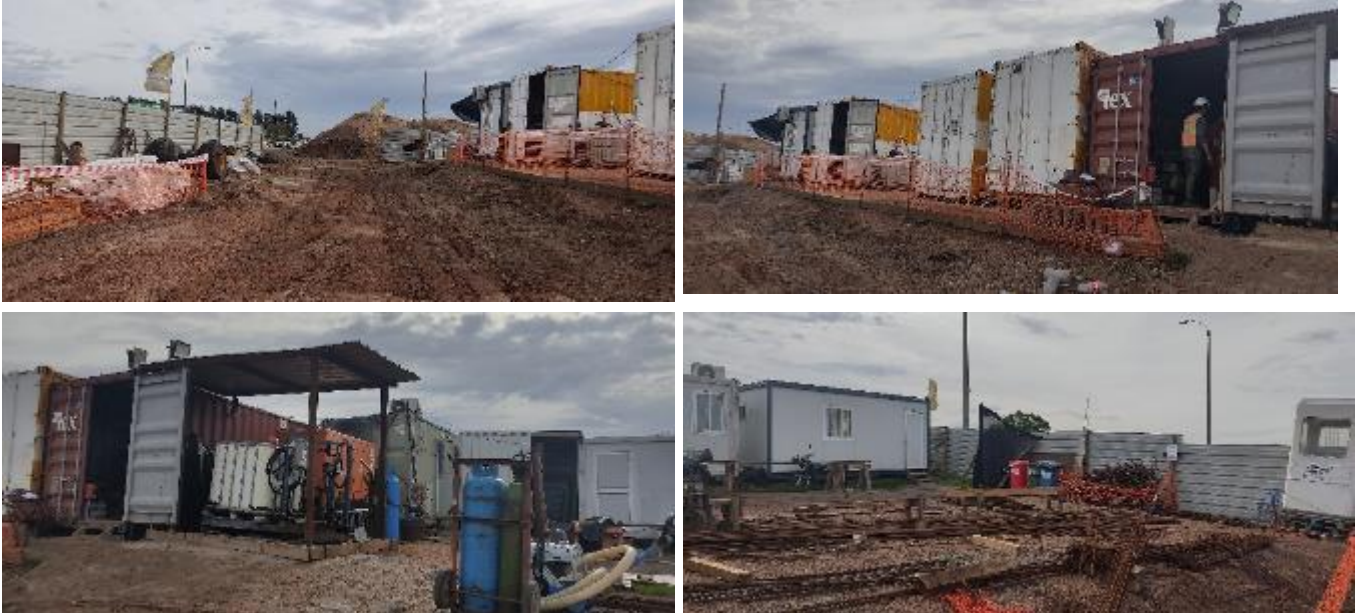
Foto 13.2-1 Vistas del Obrador de SACEEM
