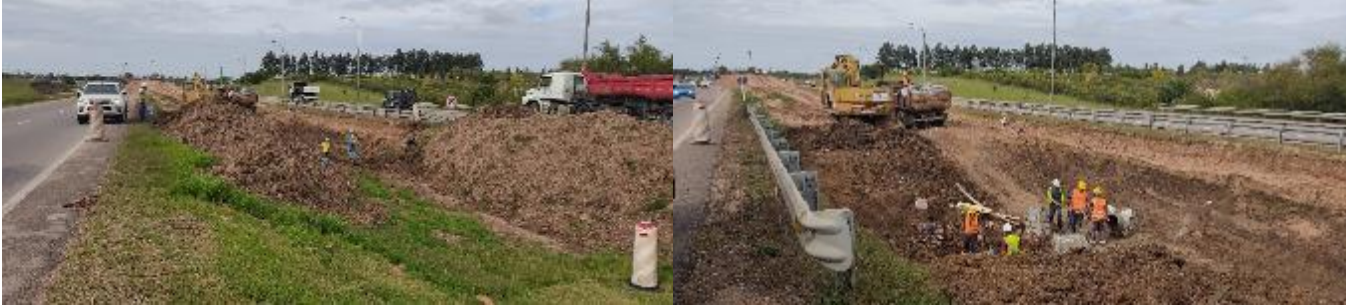
Foto 13.4-1 Construcción de Alcantarilla Subcontrato de HyG
