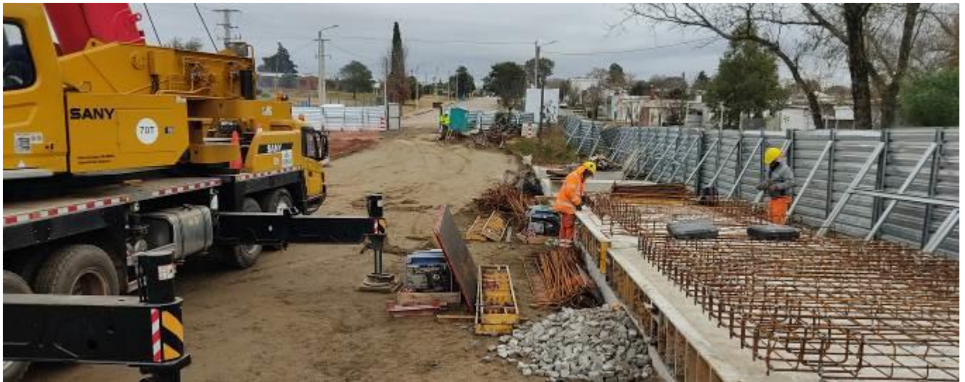
Foto 13.3-1 Vistas del Frente de Obra.
