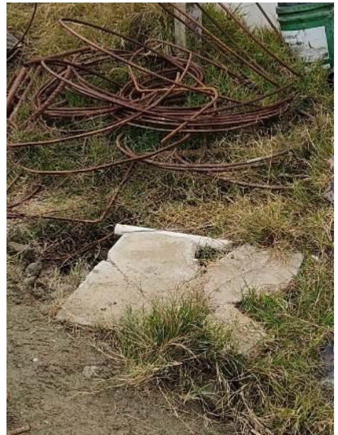
Foto 13.1-1 Tapa rota de fosa de efluentes de baños.
