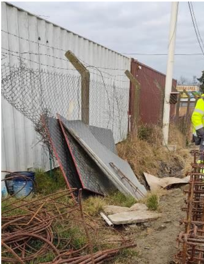
Foto 13.1-1 Tapa rota de fosa de efluentes de baños.
