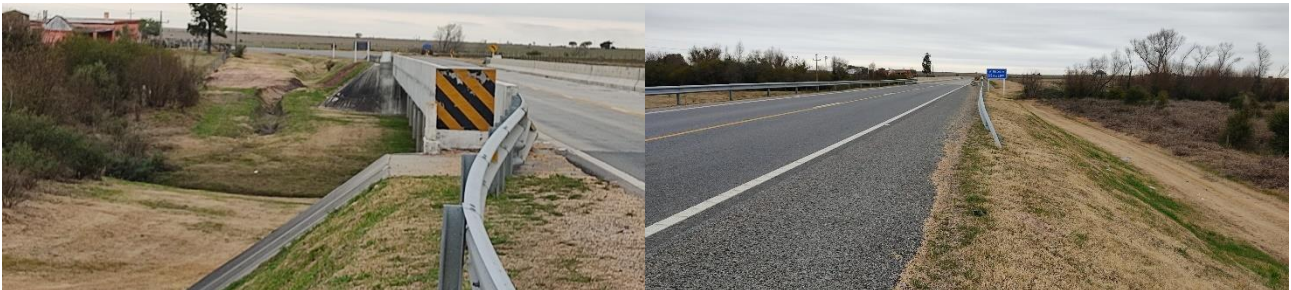
Foto 13.5-2 Puente Arroyo Bizcocho
