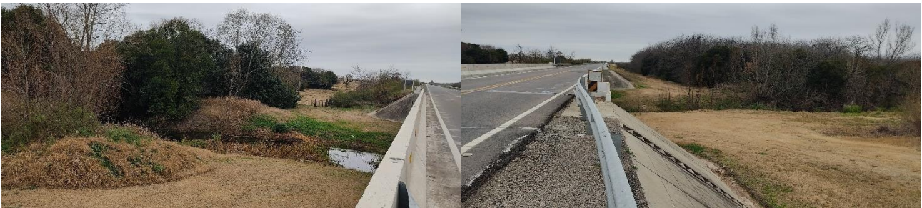
Foto 13.4-3 Puente Arroyo Arenal Chico
