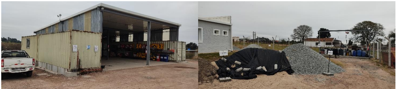
Foto 13.6-4 Vistas de Obrador de OPERADORA DEL LITORAL
