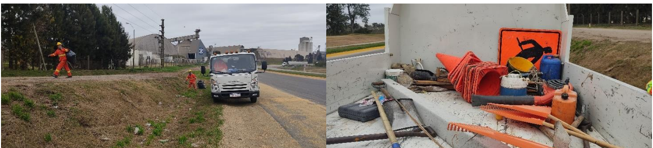
Foto 13.3-1 Cuadrilla de limpieza y corte de pasto.
