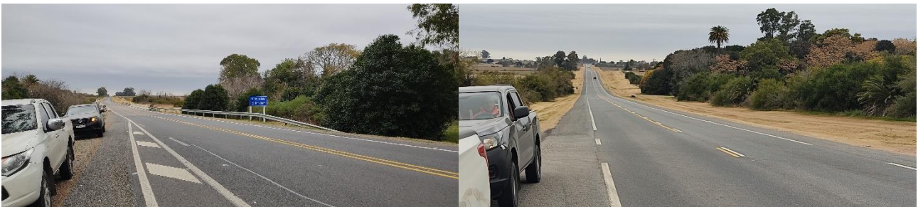
Foto 13.4-1 Puente Arroyo Agraciada
