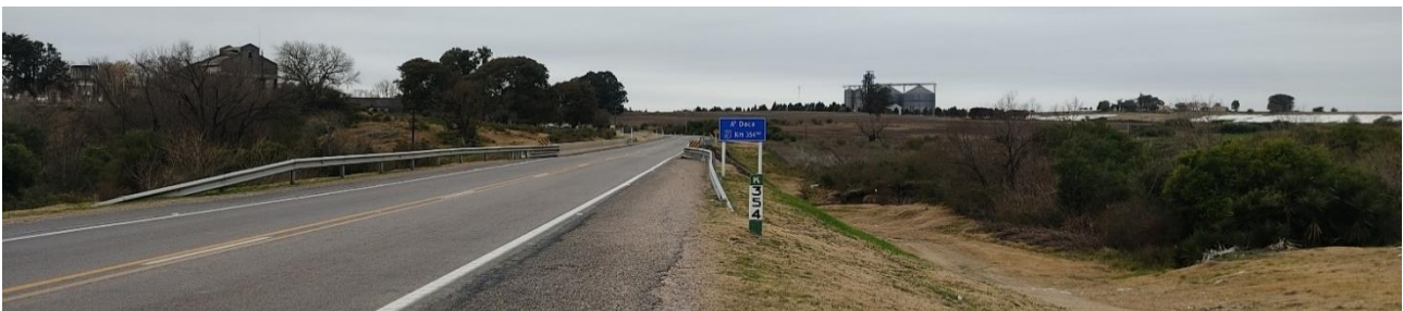
Foto 13.5-3 Puente Arroyo Daca
