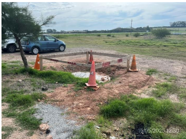
Foto 12.1-7, P03. Depósito impermeable para retención de aguas servidas
