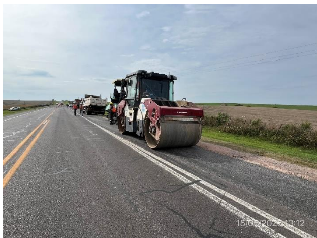
Foto 12.2-3, P04. Frente de obra, Ruta 21 progresiva 282K400, senda a (+).
