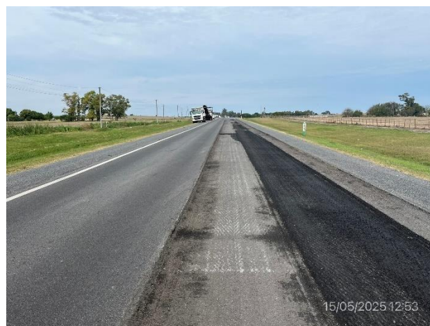
Foto 12.2-2, Ruta 21. Zona de trabajo con fresado ejecutado
