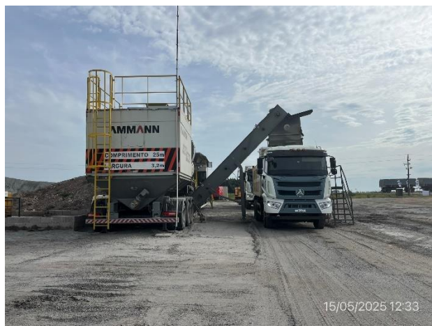
Foto 12.1-10, P03. Planta asfáltica en proceso de carga de cazamba.. Buenas condiciones de orden y limpieza
