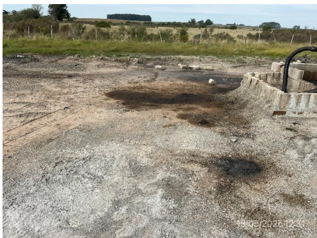
Foto 12.1-9, P03. Derrames en torno al tanque de emulsión asfáltica, pendientes de remoción y disposición final.
