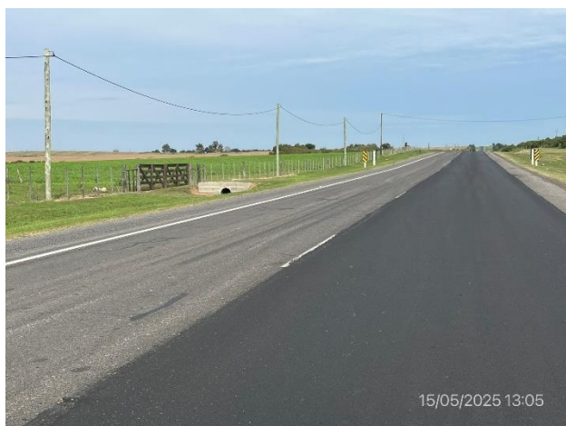
Foto 12.2-1, Ruta 21. Zona con recado ejecutado. Está pendiente la obra de señalización
