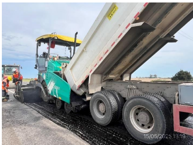
Foto 12.2-5, P04. Frente de obra, tendido de mezcla asfáltica en ejecución
