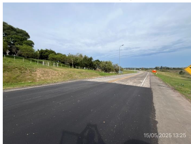
Foto 12.2-6, P02. Fin del tramo, Ruta 21 progresiva 354K800. Acceso Norte a Nueva Palmira
