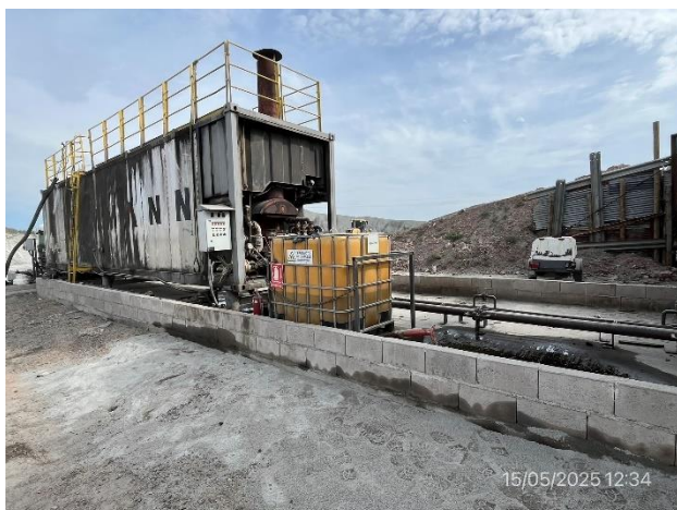
Foto 12.1-11, P03. Planta asfáltica, envallado perimetral correcto.
