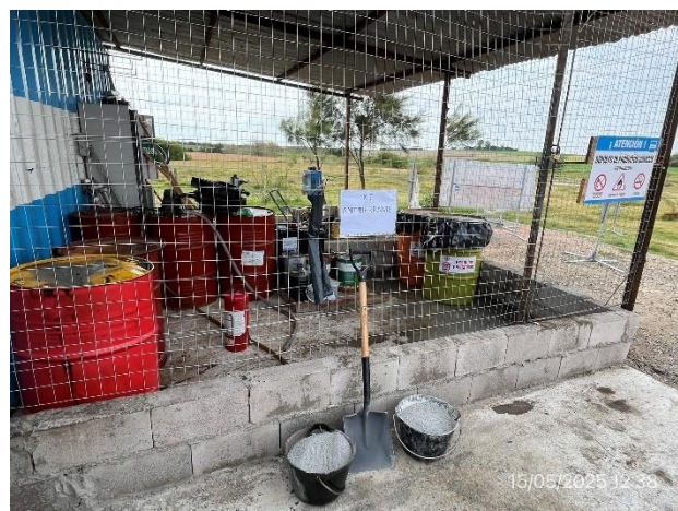
Foto 12.1-6, P03. Sector techado y envallado con pavimento impermeable para acopio de lubricantes.
