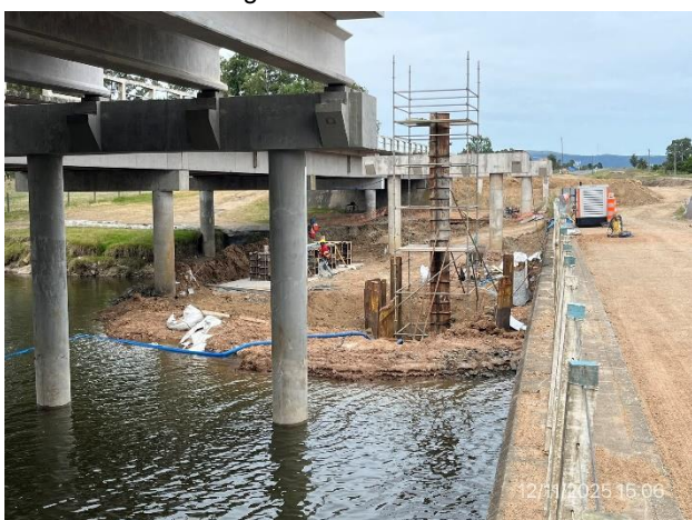
Foto 12.1-5, P01. Sector de puente con pilares en ejecución. Ataguía granular montada.
