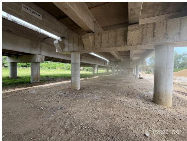
Foto 12.1-2, P01. Sector del puente con pilares, dinteles, vigas prefabricadas y tablero completado.
