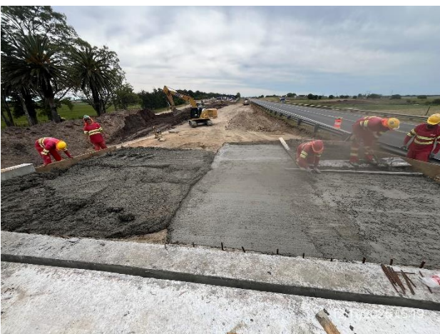
Foto 12.1-11, P01. Terraplenes de acceso al puente, ejecución de losas de transición en ejecución.
