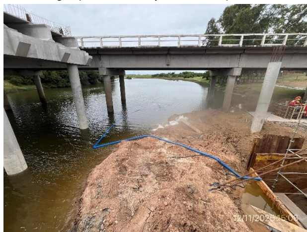
Foto 12.1-4, P01. Cauce principal desviado. Desagote de excavación por medio de bomba eléctrica.
