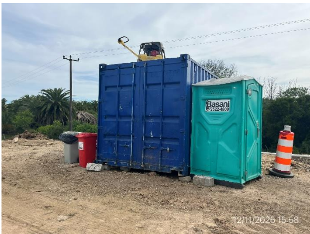
Foto 12.2-5, P02. Campamento provisorio, están presentes los servicios de bienestar y la infraestructura para el acopio temporal de residuos segregados desde origen.
