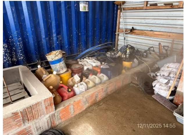
Foto 12.3-4, P03. Recinto envallado y techado conteniendo bidones con combustible y lubricantes.
