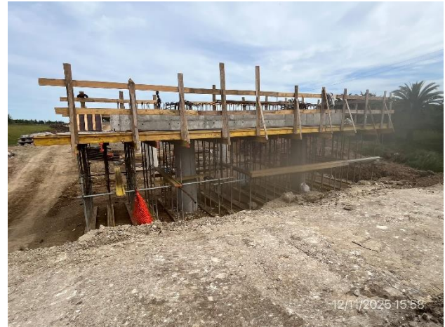
Foto 12.2-2, P02. Encofrados de dinteles en ejecución. Falta la infraestructura para el acopio temporal de residuos segregados en origen.
