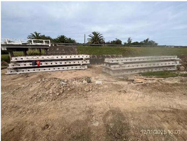
Foto 12.2-3, P02. Acopio de losetas prefabricadas
