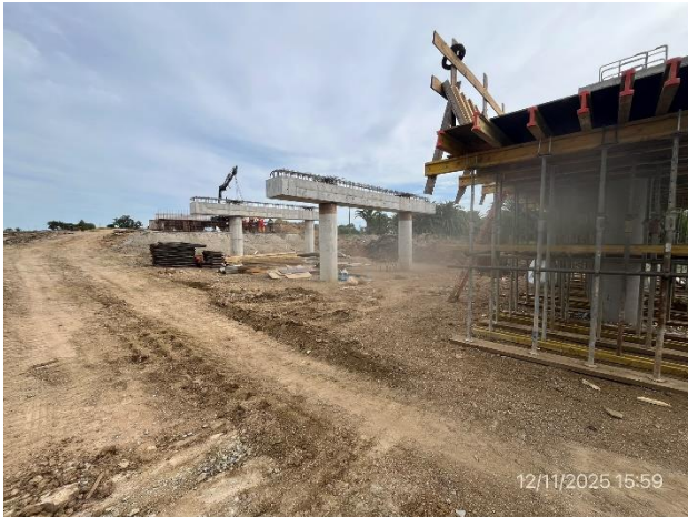
Foto 12.2-1, P02. Puente en obra sobre A° Sarandí. Ruta 9 progresiva 85K000
