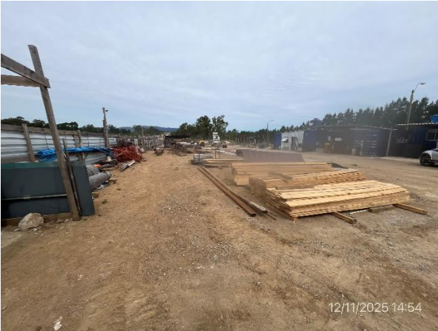
Foto 12.3-1, P03. Obrador de Stiler SA. Ruta 9 progresiva 80K650 a (+).
