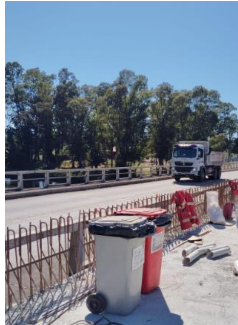
Foto 12.4-2, P01. Se reforzó la infraestructura para el acopio temporal de residuos en la zona de trabajo del tablero
