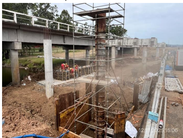
Foto 12.1-6, P01. Frente de obras, pilar en ejecución.
