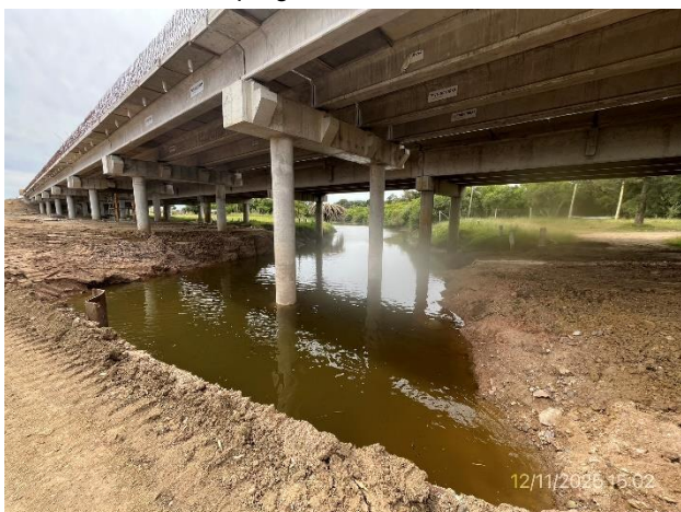
Foto 12.1-3, P01. Cauce secundario entubado con ataguía granular instalada
