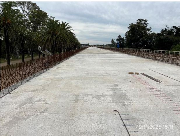
Foto 12.1-9, P01. Sector del puente con tablero parcialmente terminado.
