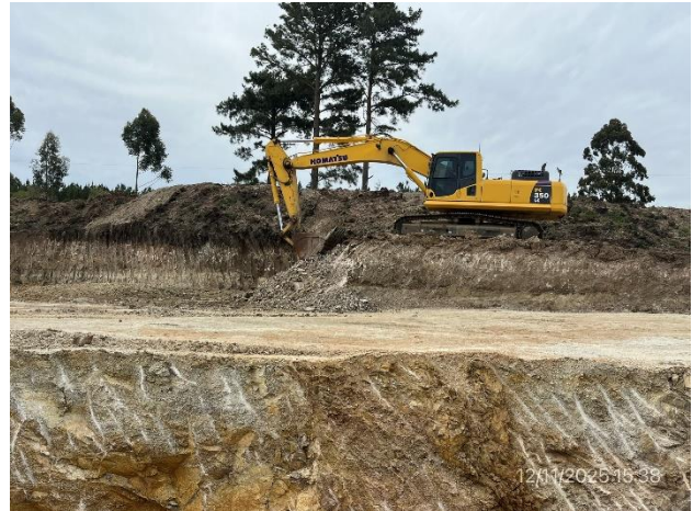
Foto 12.2-2, P04. Frente de explotación activo.
