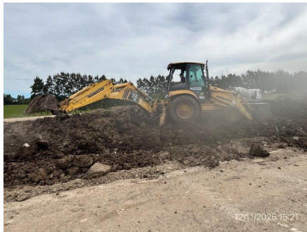
Foto 12.1-2, P06. Movimiento de suelos en ejecución.
