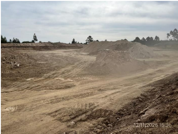
Foto 12.2-3, P04. Acopios de material listos para transporte.
