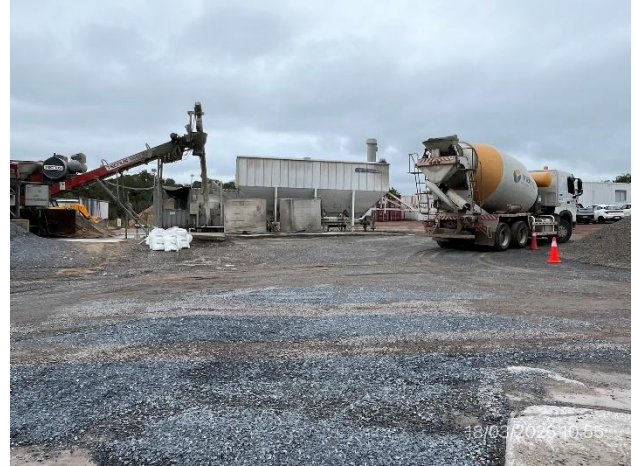
Foto 12.1-2, P03. Planta de hormigón en funcionamiento. Explanada de maniobras limpia y en buenas condiciones.
