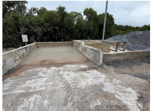
Foto 12.1-4, P03. Planta de hormigón, pileta de lavado de camiones mixer, con sistema de decantación.
