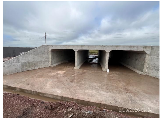
Foto 12.2-10, A09. Ruta 14 progresiva 265K600, alcantarilla con estructura terminada, zona limpia, libre de residuos.
