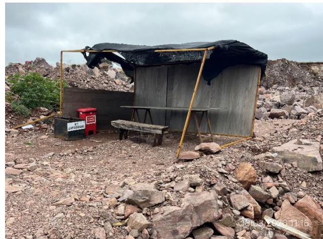
Foto 12.1-22, P06. Están disponibles las tarrinas para acopio segregado de residuos en origen y el kit para atención de derrames.
