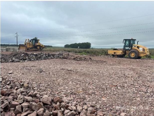
Foto 12.2-3, P07, Ruta 14 progresiva 265K150. Frente de obras vial, perfilado de pedraplén en ejecución.
