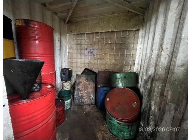
Foto 12.1-8, P04. Acopio de lubricantes en buenas condiciones, cerrado y con envallado perimetral.
