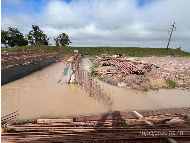
Foto 12.2-7, A25. Ruta 14 progresiva 268K900, alcantarilla en ejecución. Hay insumos y residuos flotando, sin infraestructura para su acopio segregado desde el origen.
