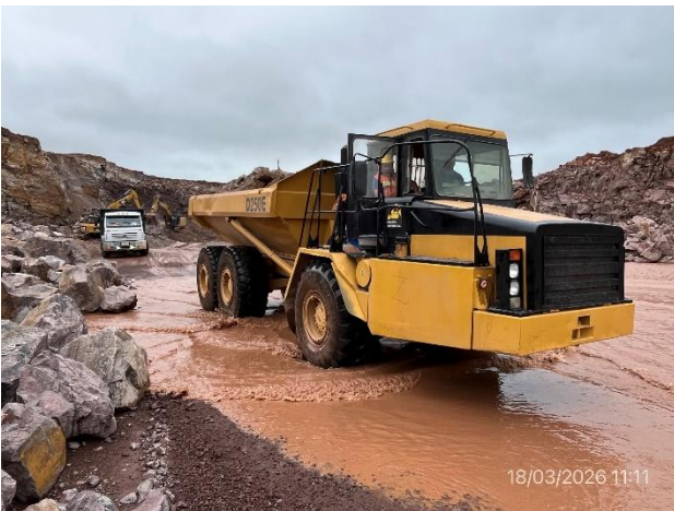
Foto 12.1-21, P06. Tareas en ejecución de acarreo hacia acopio secundario.
