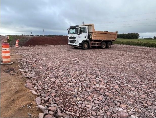
Foto 12.2-1. Pedraplén para tramo elevado de Ruta 14 en construcción.
