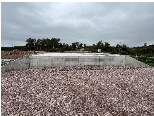
Foto 12.2-11, A21 Ruta 14 progresiva 267K300, alcantarilla con estructura terminada, zona limpia, libre de residuos.
