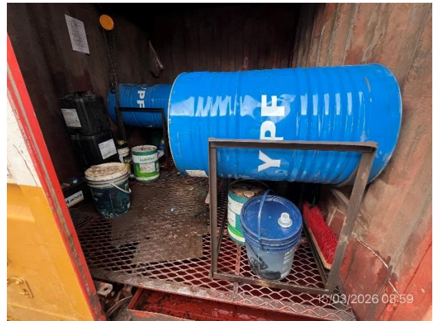
Foto 12.1-16, P05. Acopio de lubricantes en local cerrado y envallado.
