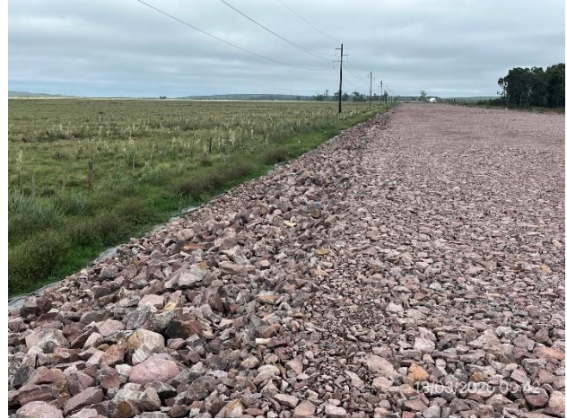
Foto 12.2-2, Ruta 14. Pedraplén conformación altimétrica de taludes en ejecución.
