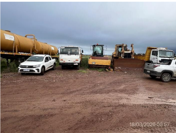
Foto 12.1-17, P05. Plataforma de maniobras, buenas condiciones de orden.
