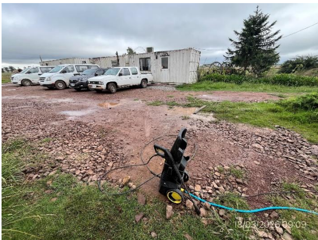
Foto 12.1-11, P04. El lavado de maquinaria se realiza sobre suelo natural.
