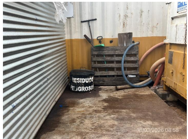
Foto 12.1-18, P05. Explanada de acopio de residuos, buenas condiciones de orden.
