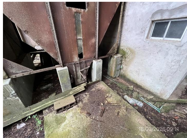
Foto 12.1-12, P04. El pozo hacia donde escurren las aguas servidas es preexistente a la instalación del obrador de la empresa en el predio.
