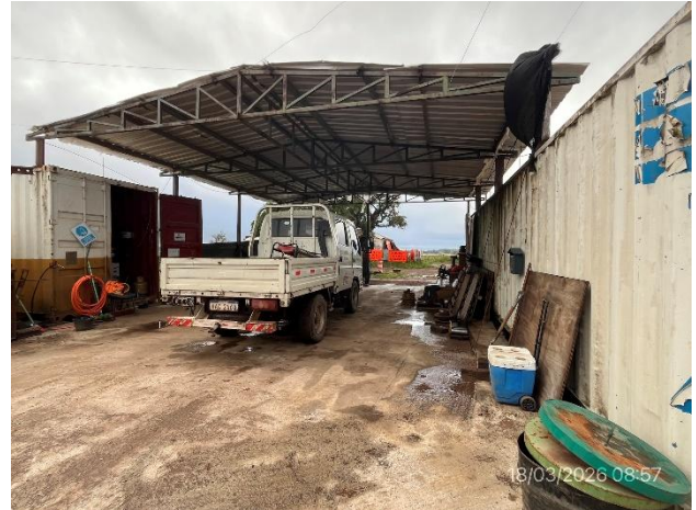
Foto 12.1-14, P05. Obrador de Tafarol SA. Taller mecánico bajo techo y con pavimento impermeable.
