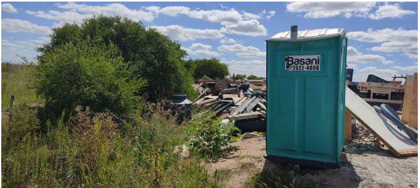
Foto 13.1-1 Acopios sobre vegetación existente en el predio.
