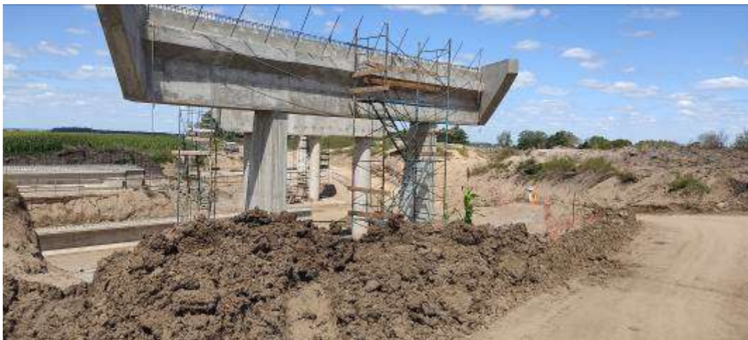
Foto 13.3-1 Vistas del Puente en obra
