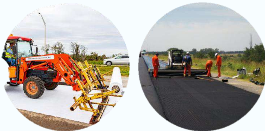
Foto 1. ejemplos de extensión mecánica de geosintéticos.
