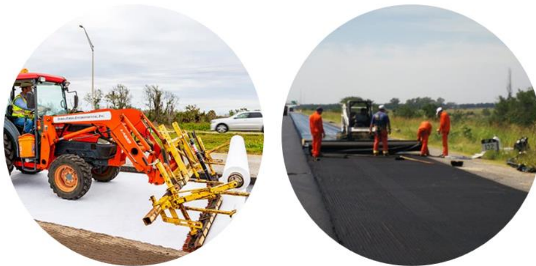
Foto 1. EJEMPLOS DE EXTENSIÓN MECÁNICA DE GEOSINTÉTICOS.
