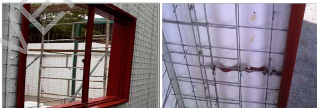
Fig. 13_ Amure de abertura con premarco con bigotes
