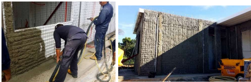
Fig. 20_ Aplicación de la primera mano de mortero estructural (“rigidización” o azotada)
