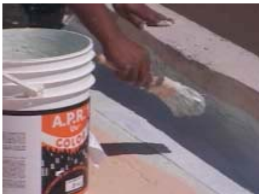
PREPARACIÓN DE PRETILES CON BAND SEAL
