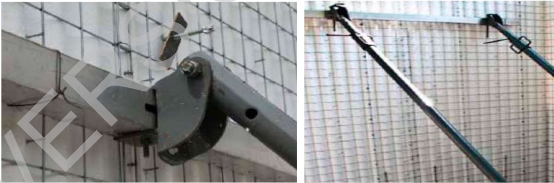
Fig. 8_ Apuntalamiento de paredes
