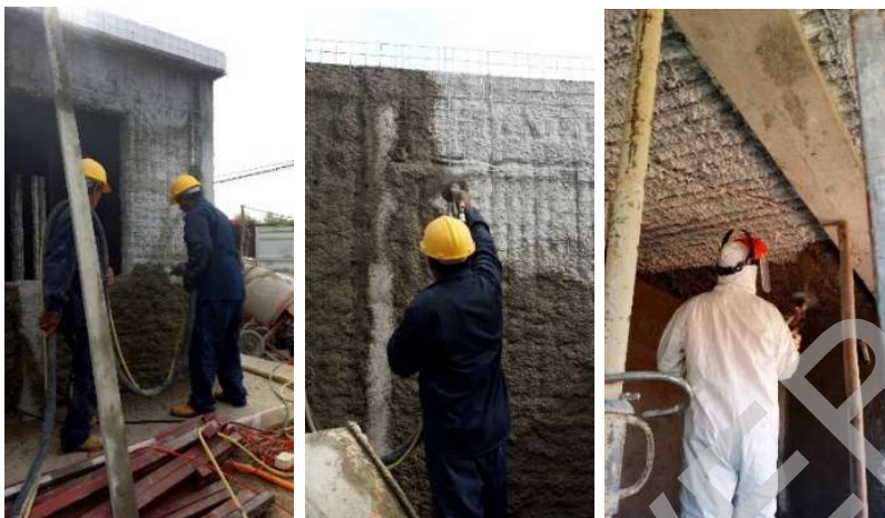
Fig. 24_ Proyectado de segunda mano de mortero estructural en paredes y cielorraso
