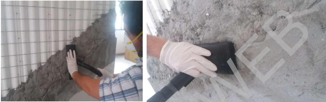
Fig. 26_ Preparación de superficie por medio de aspiradora industrial
