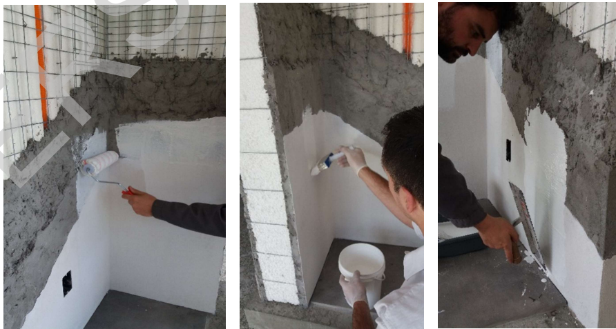
Fig. 27_ aplicación con rodillo (izq.), aplicación con pinceleta y llana (centro y der)
