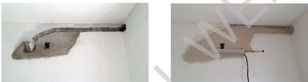
Fig. 42_ Retiro de mortero y marcado de nueva canalización. Corte de malla y canalización de nueva instalación.
