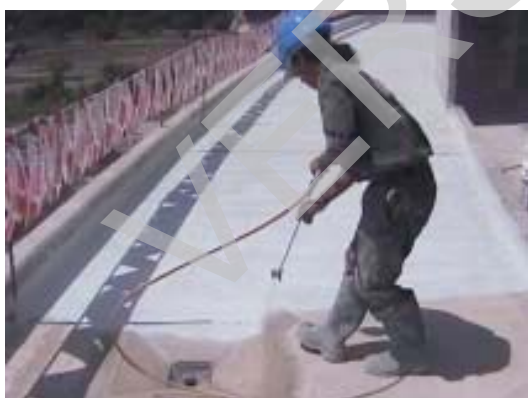
APLICACIÓN CON AIRLESS
