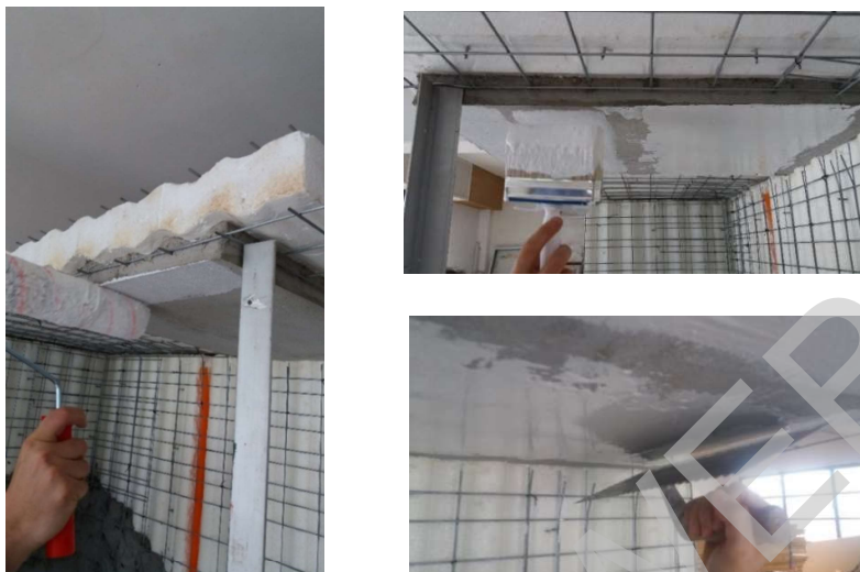
Fig. 28_ Aplicación en horizontal con rodillo, pinceleta y llana
