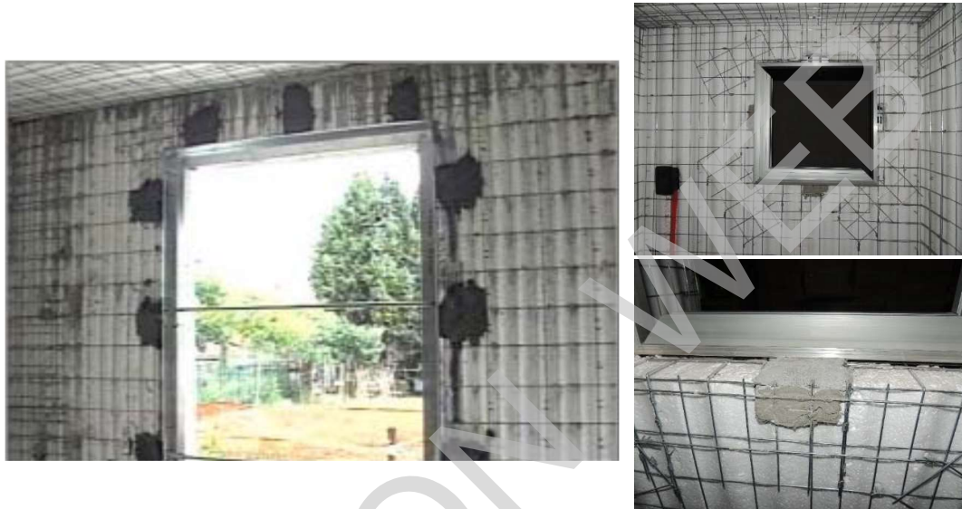
Fig. 12_ Amure de abertura con grapas en premarco
