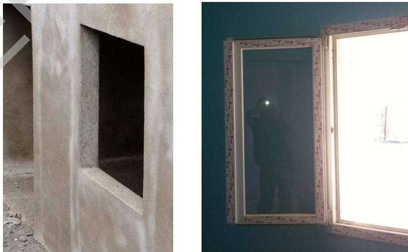
Fig. 11_ Amure de abertura con poliuretano expandido o anclaje mecánico
