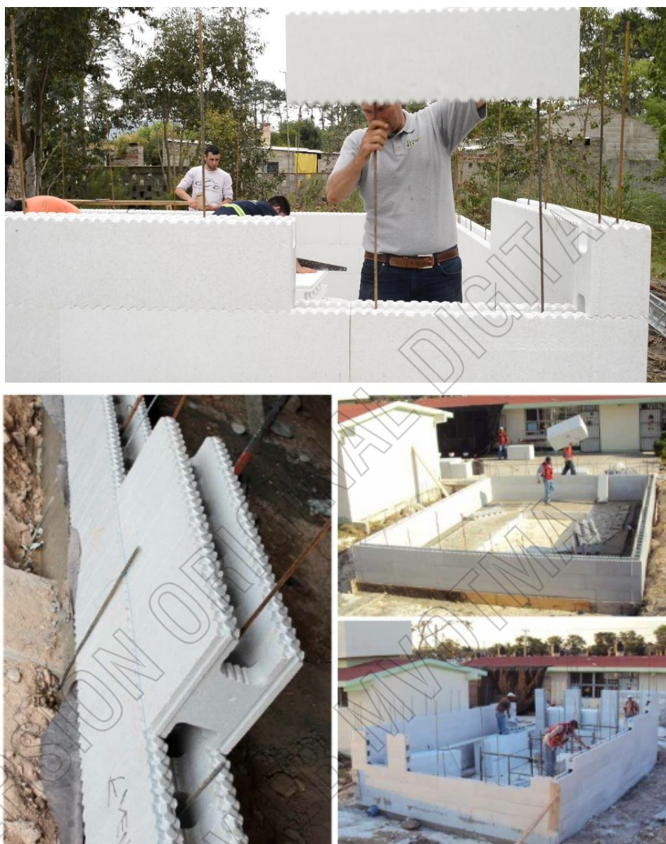
Figura 9: imágenes de armado de muros de Block ICF RST ®
