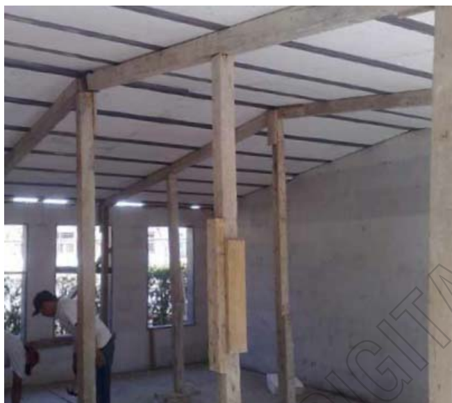
Figura 18: Imagen de apuntalado de techos inclinados
