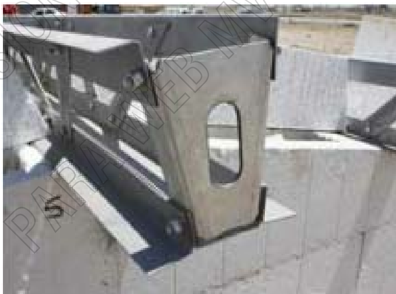
Figura 17: Imagen de cumbre realizada con dos Joists RST®.
