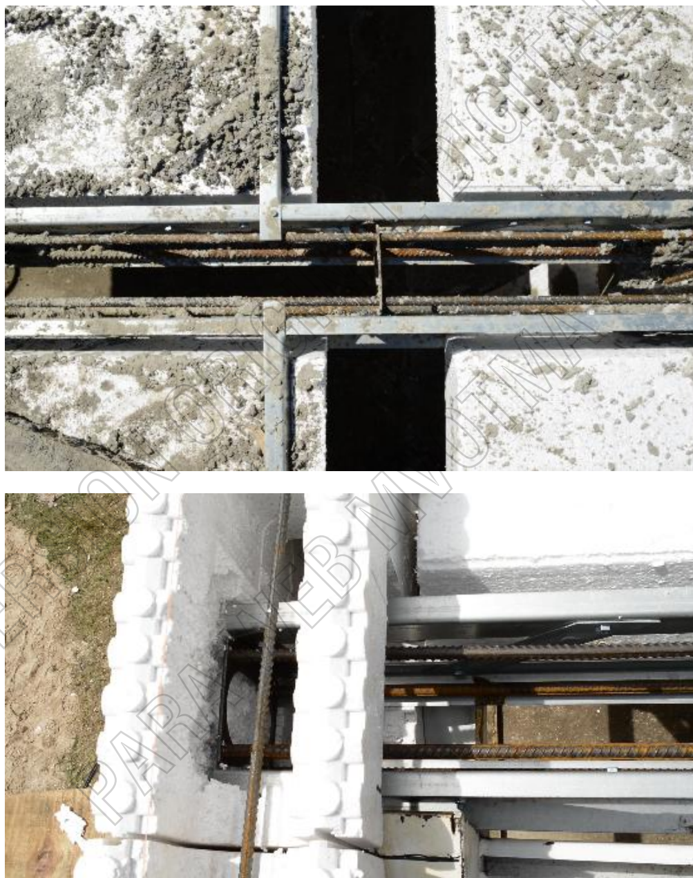
Figura 15: Imágenes de zonas de entrepiso en las que se colocan refuerzos estructurales en dirección paralela a los Joists RST
