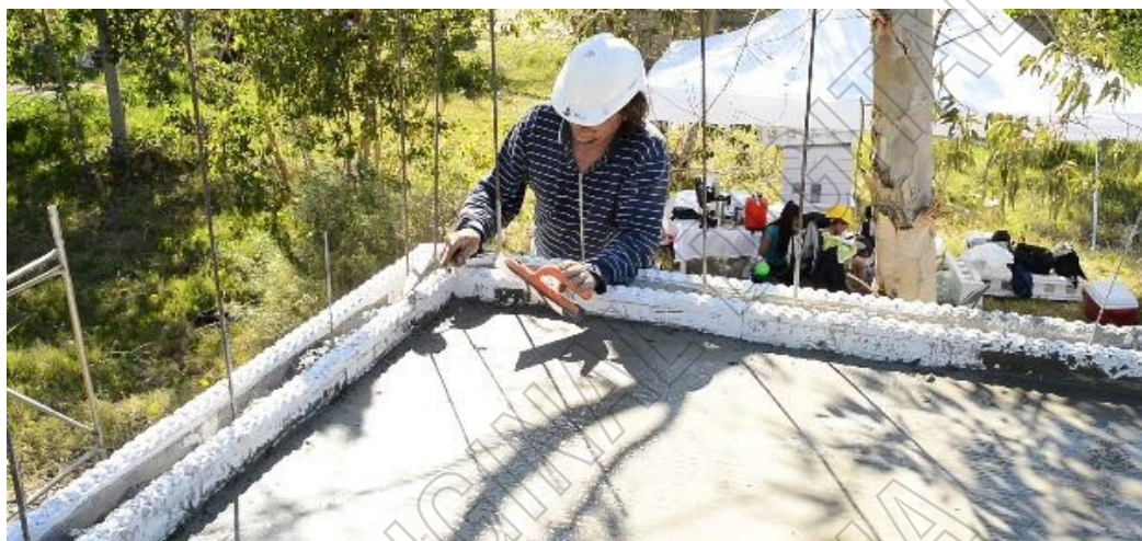
Figura 16: Imagen de entresijo luego de llenado de la carpeta de compresión
