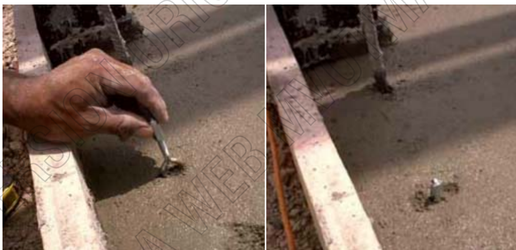
Figura 8: imágenes de colocación de pitones con extremo roscado en el hormigón fresco, para fijar las varillas roscadas
