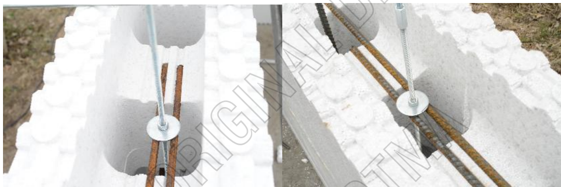
Figura 3: Imágenes del mecanismo de varilla roscada, arandelas, tuercas y barras para mantener los bloques en la posición adecuada durante el colado de hormigón
