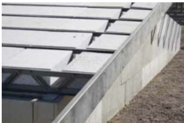
Figura 19: Imagen de techo con voladizo, con borde de chapa plegada en forma de canal
