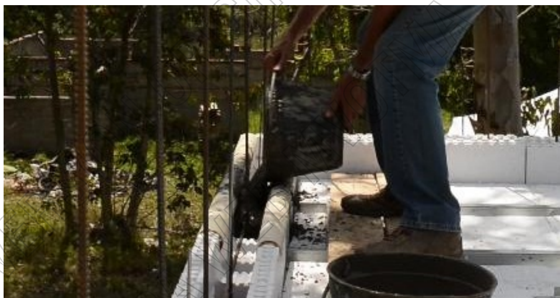
Figura 12: Imagen de llenado de muro
