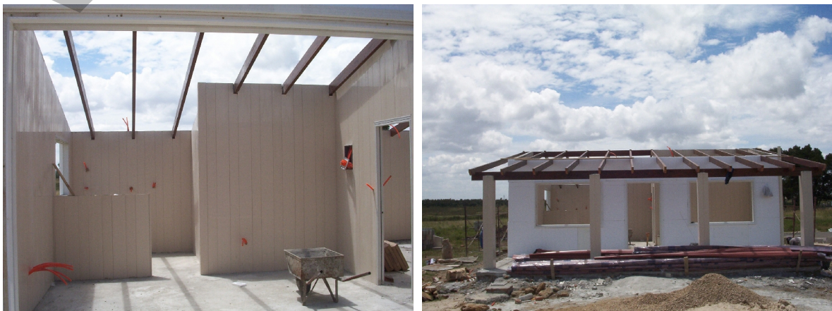
Cubierta liviana sobre tirantería de madera
