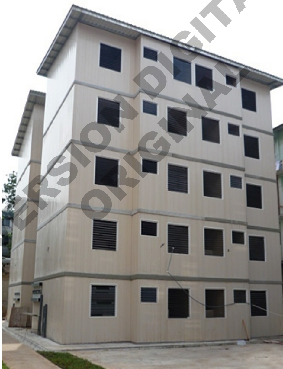
Edificio RBS en altura (5 niveles), Colombia.
