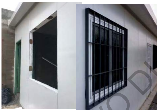
Tacos de madera para fijación de aberturas.
