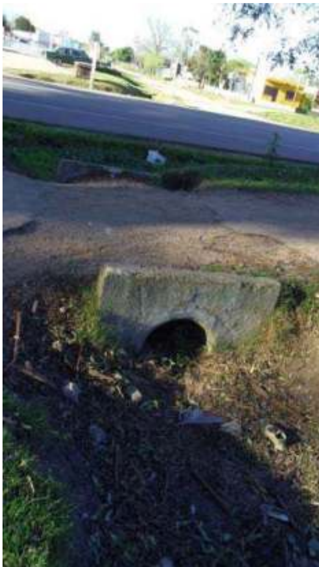
Figura 13. Empalme de la zanja de la calle Rodolfo Torres García con la cuneta de la Ruta 11.
