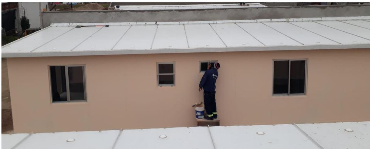
El sellado entre la cubierta de paneles y el muro de albañilería (entre dos viviendas) se realiza con membrana asfáltica pegada al panel y al muro de mampostería. Se le coloca una babeta de chapa prepintada blanca, para proteger la membrana, y va amurada al muro de mampostería con mortero con hidrófugo. Si llegase a ingresar humedad al interior de la vivienda por el muro de mampostería, se deberá revisar la membrana asfáltica y evaluar si es necesario volver a pegarla o sustituirla.
