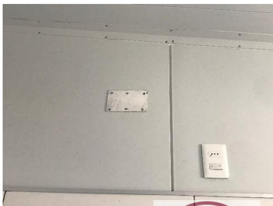
Se aconseja evitar amurar en la cubierta y en los muros exteriores, cables con grapas, antenas, etc., sin asesoramiento previo, dado que puede afectar su hermeticidad al agua.
