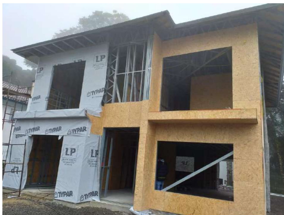
MONTAJE DE PLACAS OSB Y MEMBRANA IMPERMEABLE
