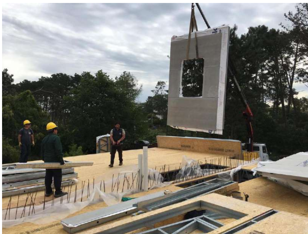
MONTAJE DE PANELES EN OBRA
