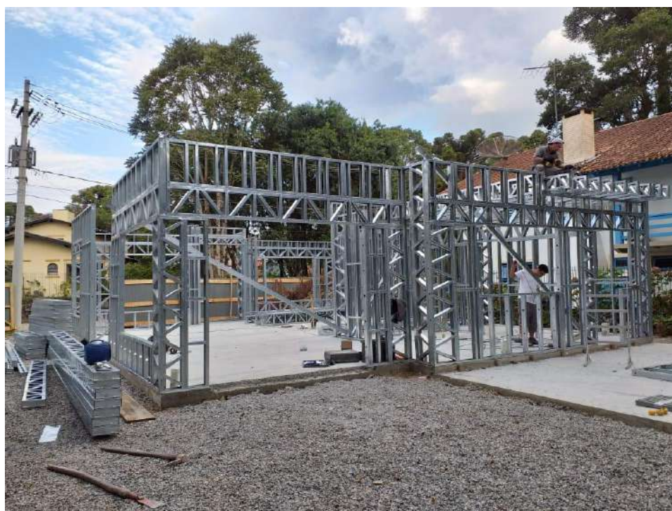
MONTAJE DE ESTRUCTURA
