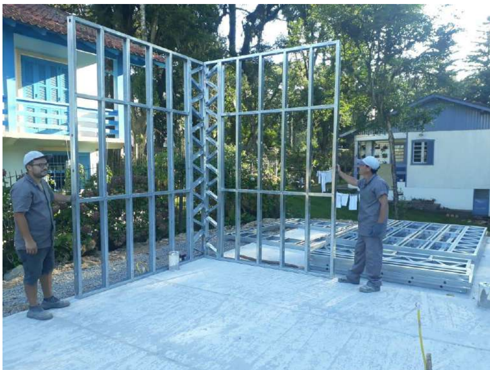
MONTAJE DE ESTRUCTURA
