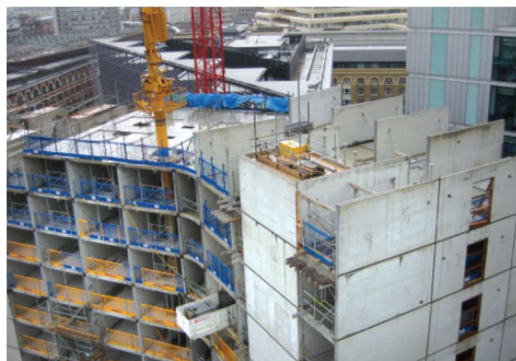
Ilustración 4 – Ejemplo de edificio con muro portante
