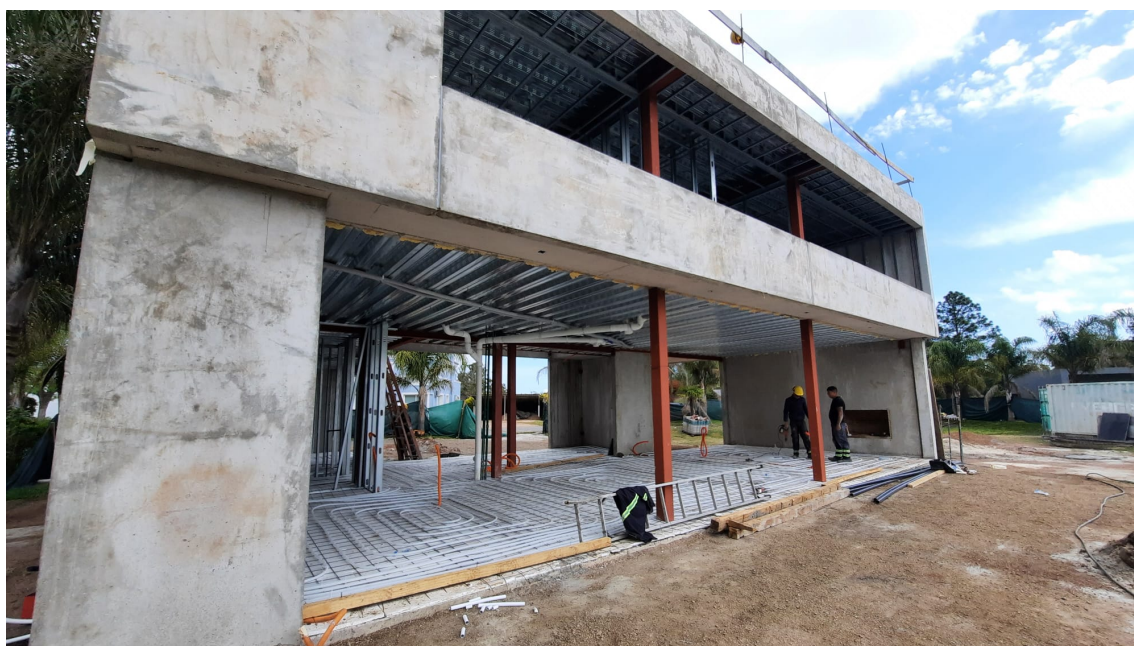
Ref: 10 / Vista frontal vivienda unifamiliar en proceso de construcción.
