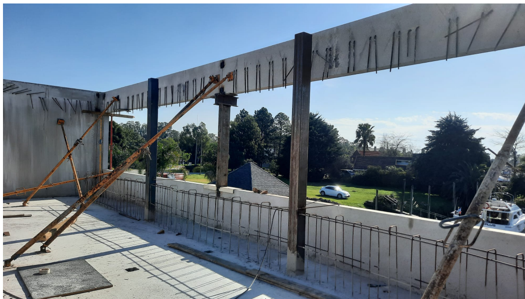
Ref: 8 / Vista de los puntales direccionales para placas.
