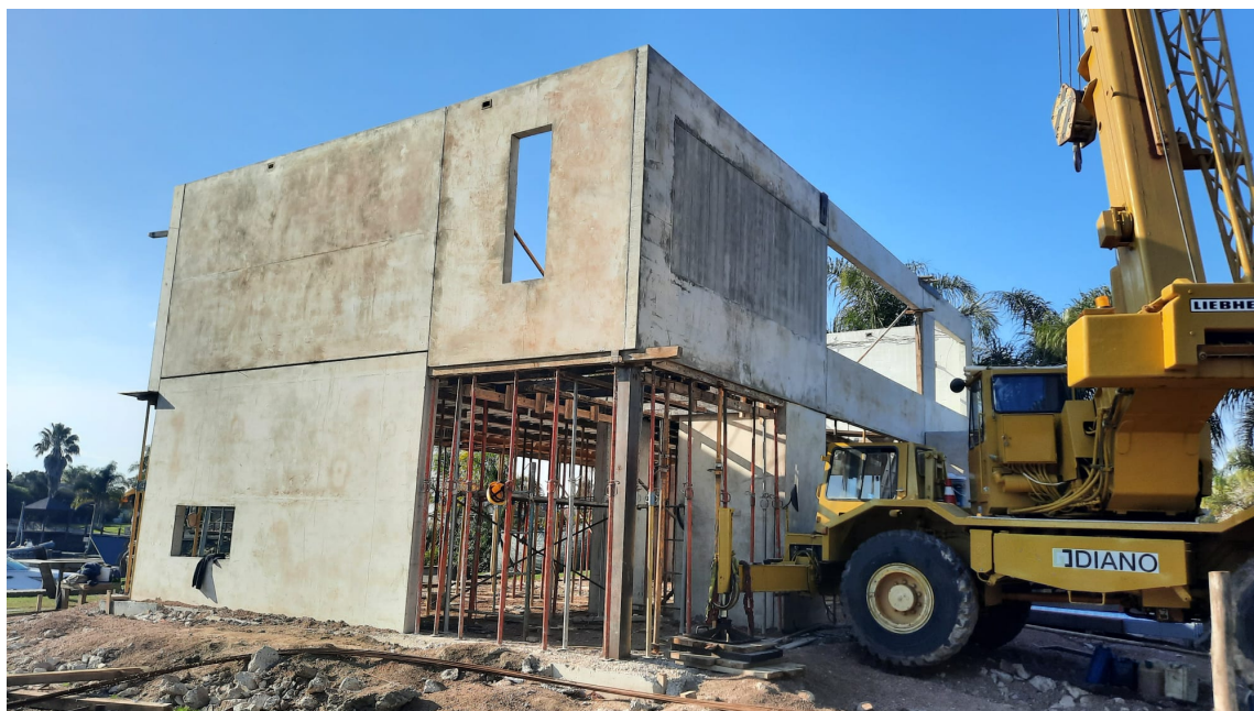
Ref: 11 / Vista lateral vivienda unifamiliar en proceso de construcción.
