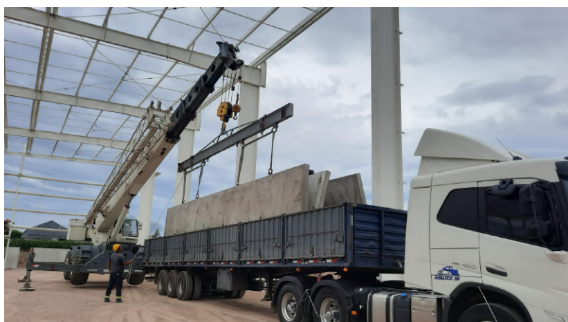
Ref: 7 / Estanterías metálicas para apoyo de placas en obra
