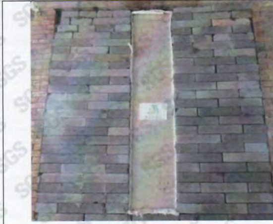
The unexposed face before test item 4 Cara no expuesta previo a la prueba de item 4.
