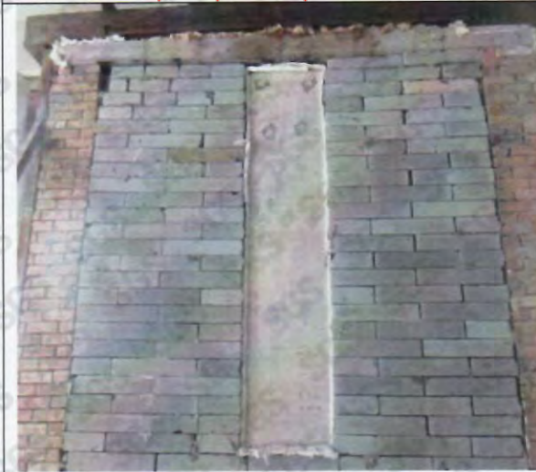
The unexposed face after test item 4 Cara no expuesta después de la prueba de item 4.
