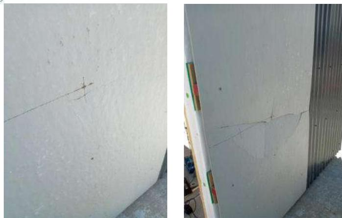
Figura N°4. Vista de daños en placa cementicia,
