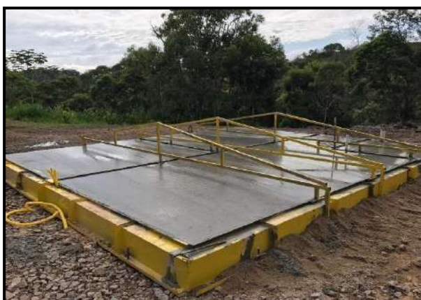
Figura 75 – Platea después hormigonado y superficie acabada.
