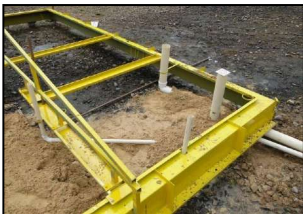
Figura 72 – Posicionamiento de las tuberías hidrosanitarias.
