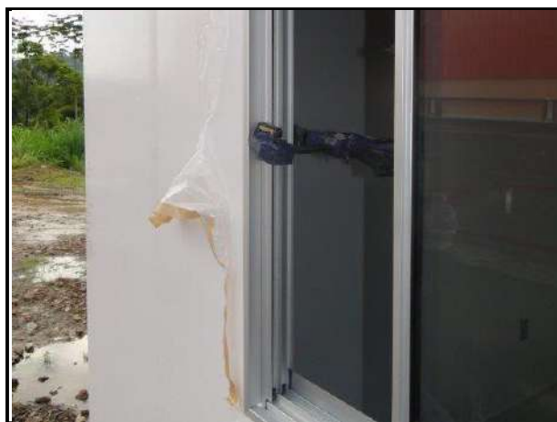
Figura 49 – Encaje del cuadro de la ventana.
