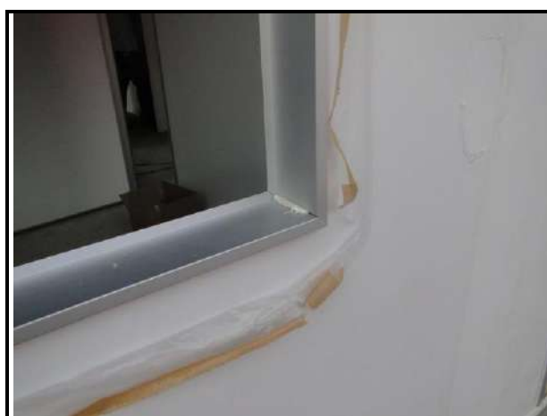
Figura 47 – Encaje de los contramarcos.
