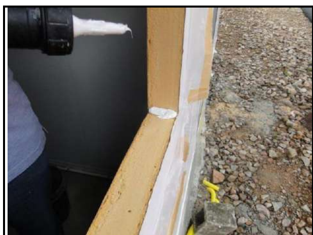
Figura 46 – Aplicación sellante en canto del recorte para la ventana.
