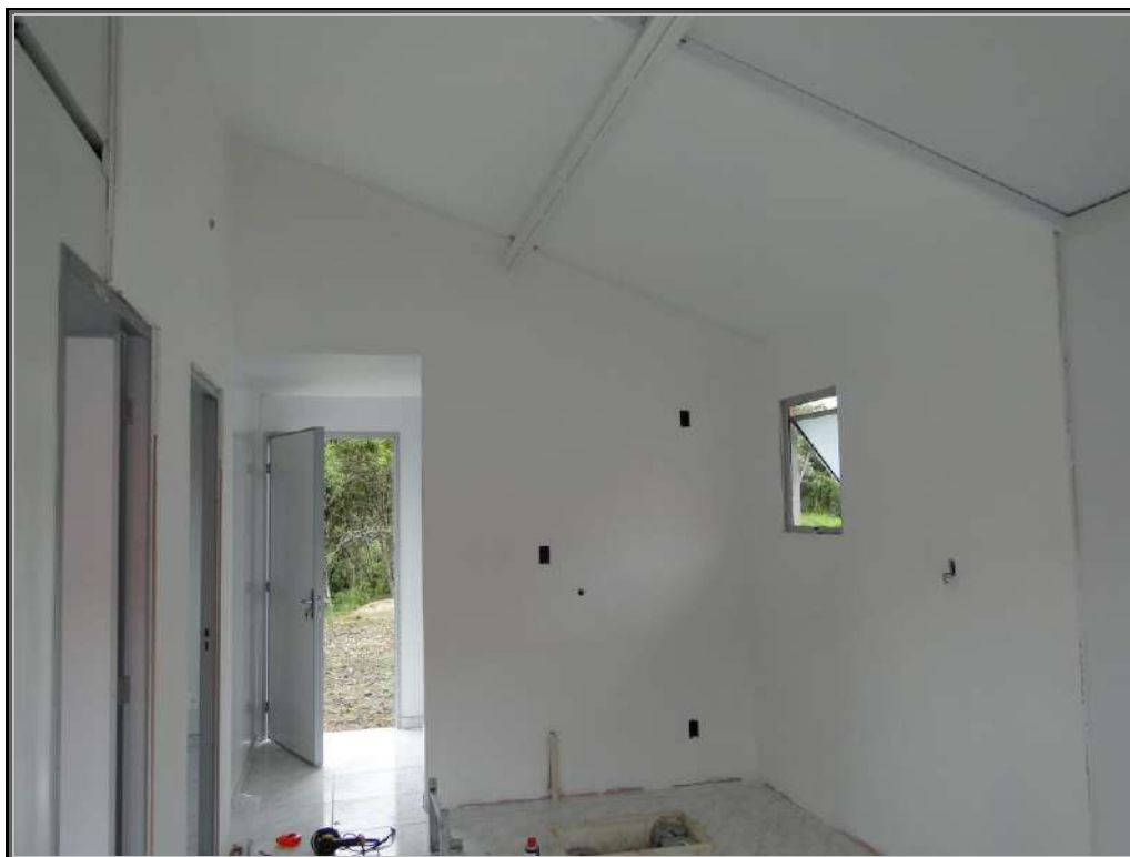
Figura 85 – Vista general del revestimiento en chapas de yeso cartón (prototipo en fábrica).
