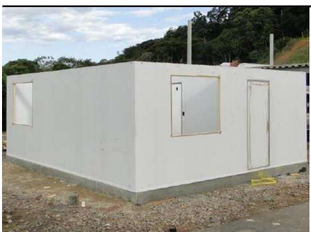
Figura 81 – Fin del montaje de las paredes y encuadre final.
