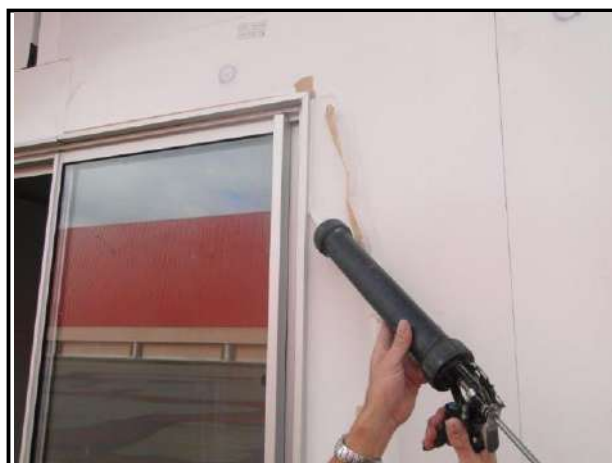
Figura 51 – Sellado con sellante de las extremidades de la ventana.
