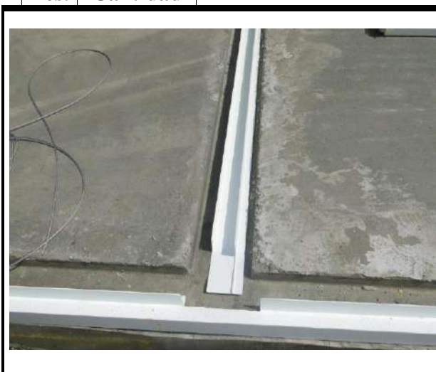
Figura 77- Perfil de PVC para fijación pared con la fundación.
