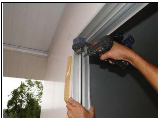
Figura 50 – Fijación de la ventana con tornillo.
