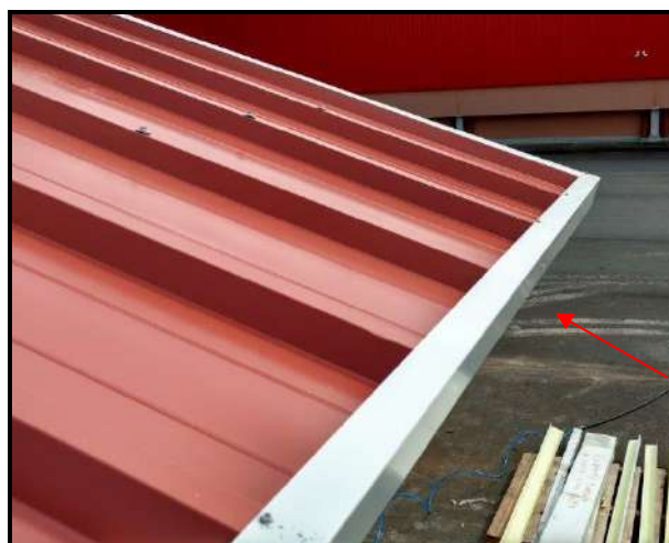
Figura 84 – Instalación tapa juntas acabamiento.
