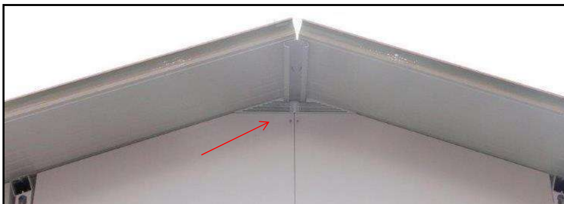
Figura 70 – Ubicación de la rejilla de ventilación
