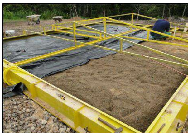
Figura 73 – Tierra en interior de la forma y colocación de la lona plástica.
