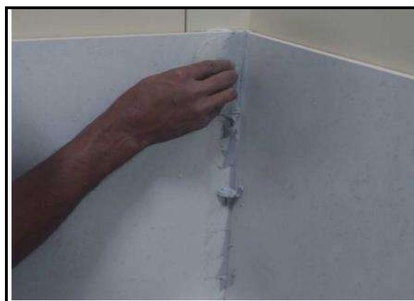
Figura 13- Rejunte epoxi entre las cerámicas.
