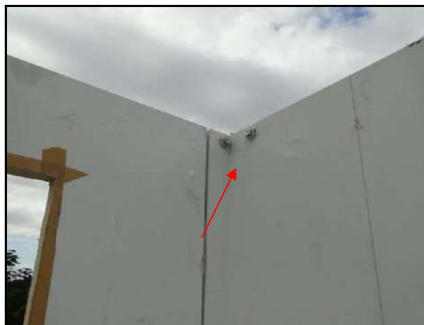
Figura 80- Pins para bloqueo (panel "L").
