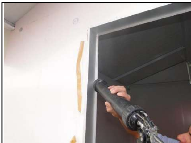
Figura 48 – Aplicación sellante en la parte interna de solapa.
