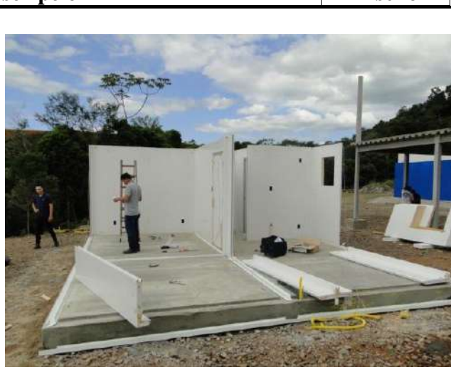
Figura 78- Inicio de montaje de los paneles de pared.
