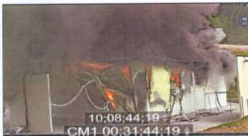
Figura 4.2 – Colapso da estrutura às 10:08h.
