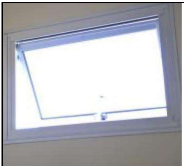
Figura 44– Ventana del baño
