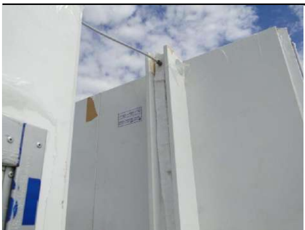
Figura 79 – Encaje macho/hembra y pasaje del cabo de acero para bloqueo.
