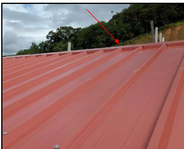
Figura 83 – Instalación de la cumbrera.
