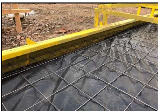
Figura 74 – Armadura platea (celosía y malla soldada)
