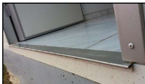
Figura 26– Solera de acero inox, protegiendo la caja “U” en PVC (área de la puerta)
