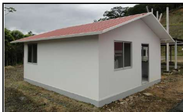
Figura 2- Casa en construcción.
