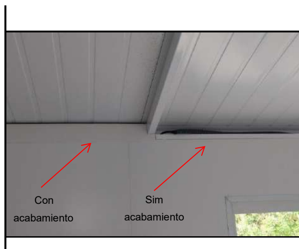
Figura 59 – Tramo para tubería eléctrica.
