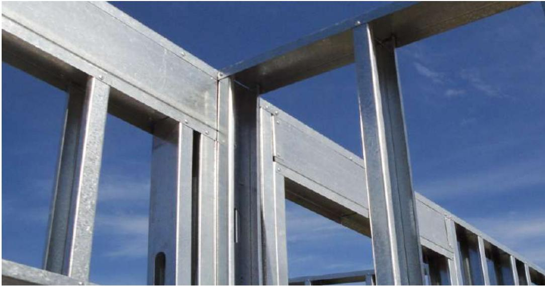
El acero es un material que posee una excelente relación resistencia mecánica / masa, pero como contrapartida requiere de una protección adecuada contra la corrosión para poder asegurar una vida útil compatible con la mayoría de los posibles destinos de la construcción.
