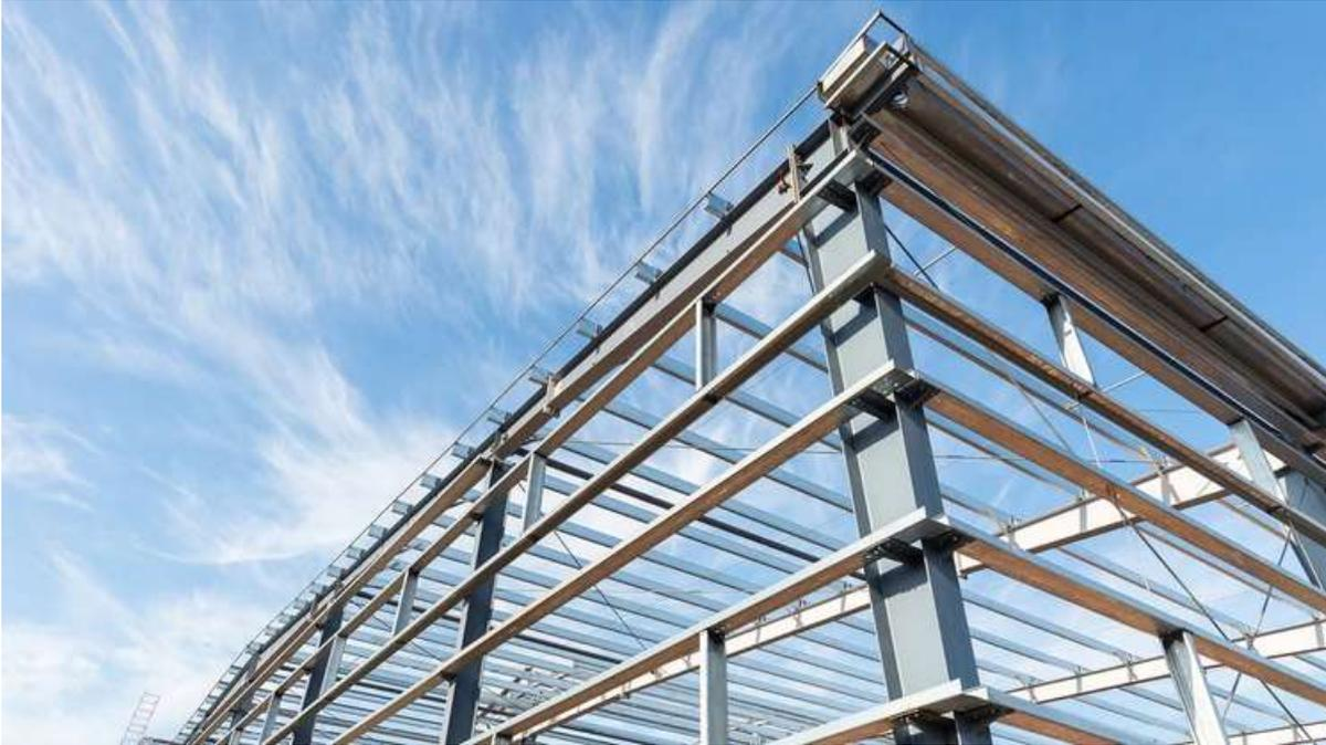
La construcción en seco y el steel framing no consumen agua durante el proceso constructivo, preservando así este valioso recurso.
