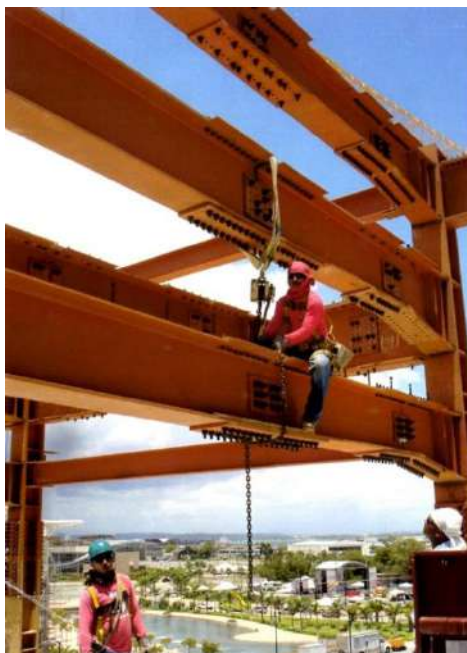
FIGURA4. IMAGEN REFERENCIAL DE MONTAJE DE ESTRUCTURA METALICA
