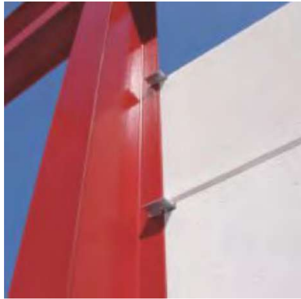
FIGURA12. DETALLE DE CONECTORES TIPO C.
