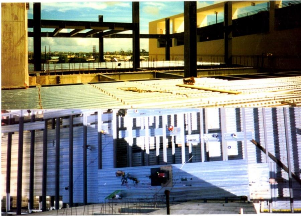
FIGURA6. DETALLE DE INSTALACION LAMINAS DECK METALICO.
