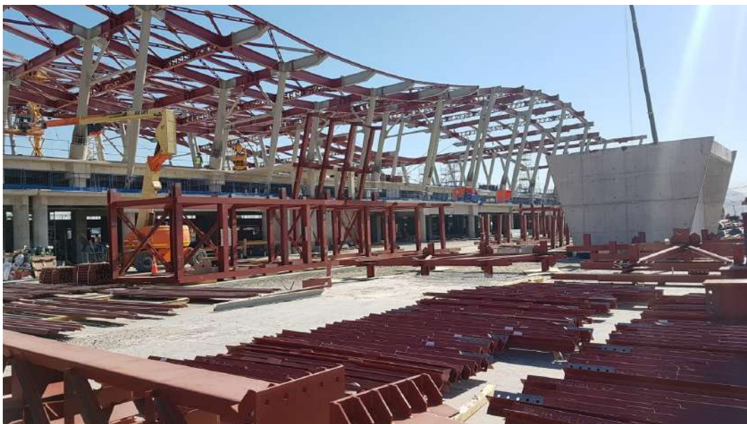
FIGURA9. IMAGEN REFERENCIAL DE ALMACENAJE DE ESTRUCTURA METÁLICA.
