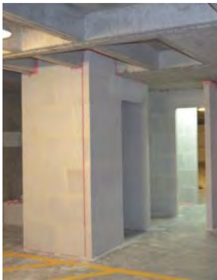
Fig. 17: Dintel y juntas de dilatación.
