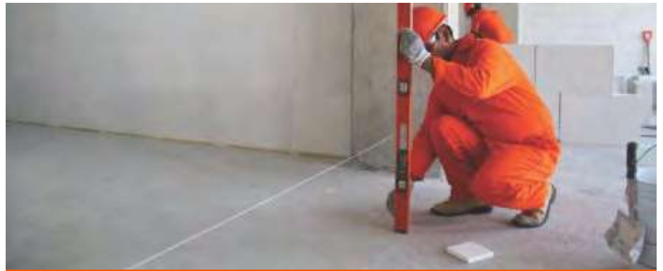
Fig. 3: Trazo y plomo para desplante.
