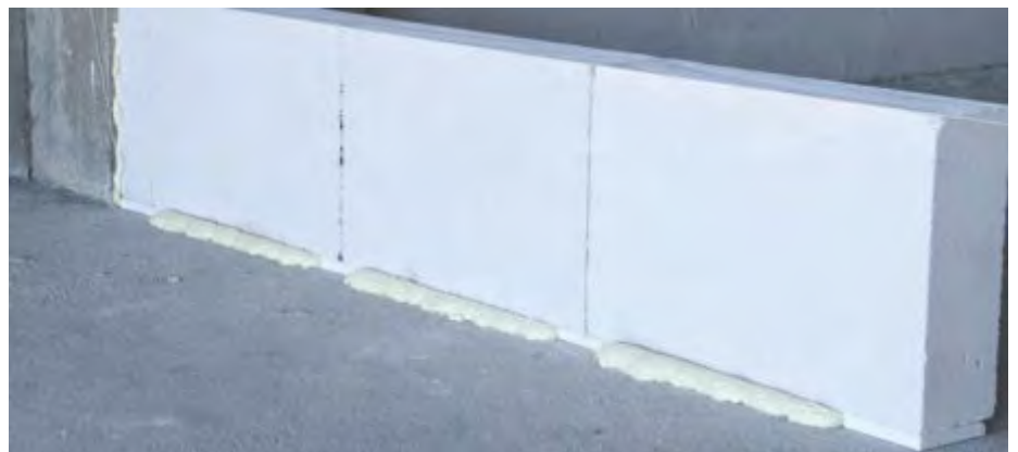
Fig. 6: Expansión de espuma de poliuretano en desplante.
