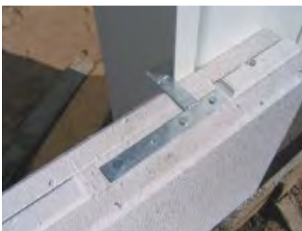
Fig. 9: Colocar el conector e hincar los clavos RG7 mediante golpe de martillo (ejemplo: conector Tipo "C").
