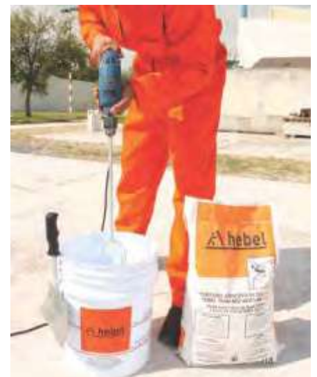
Fig. 2: Preparación de Adhesivo Hebel.
