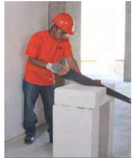
Fig. 9: Corte con serrucho Hebel.
