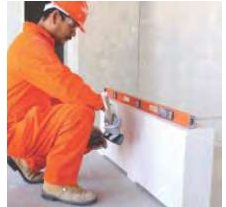
Fig. 4: Iniciar el desplante, colocando calzas.
