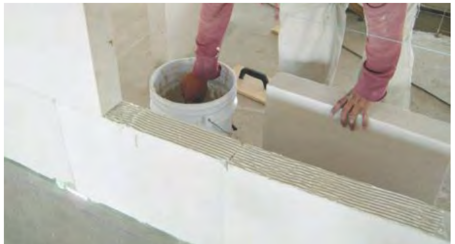
Fig. 8: Aplicación de Adhesivo Hebel.
