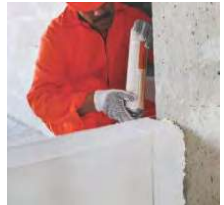
Fig. 5: Espuma Hebel en cara vertical.
