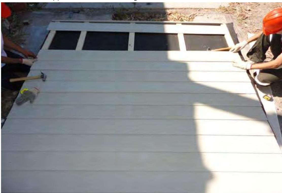
(d) Instalación de fajas de fibrocemento como revestimiento exterior.
