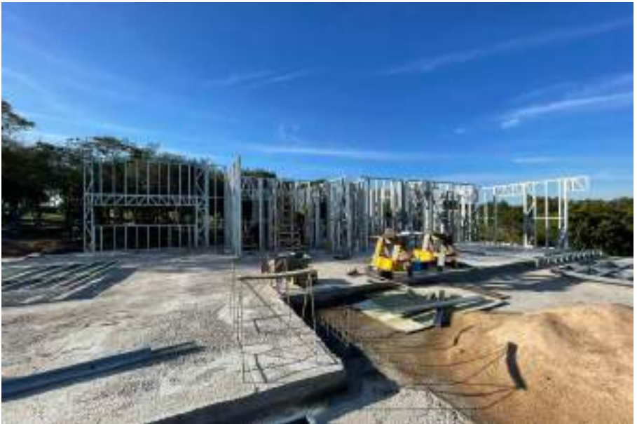
Platea de hormigón armado con vereda perimetral. Obra Río Uruguay 2021.
