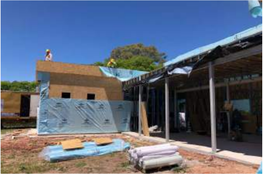
Emplacado exterior con OSB y Barrera Hidrófuga. Obra Carmelo Golf 2021.
