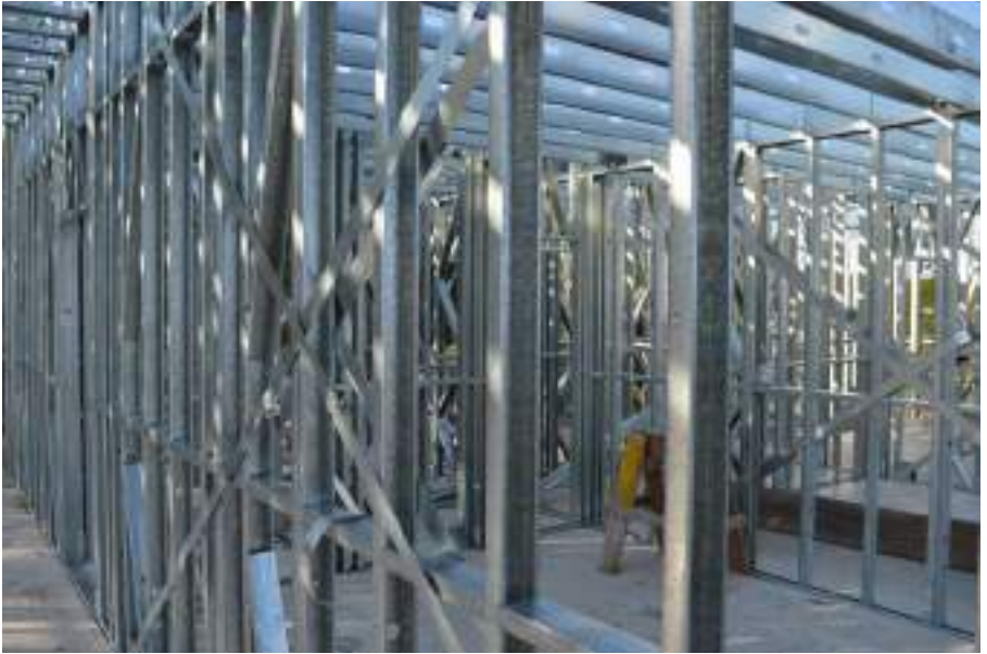
Estructura de muros en casa de Steel Framing. Obra Fray Bentos 2019.
