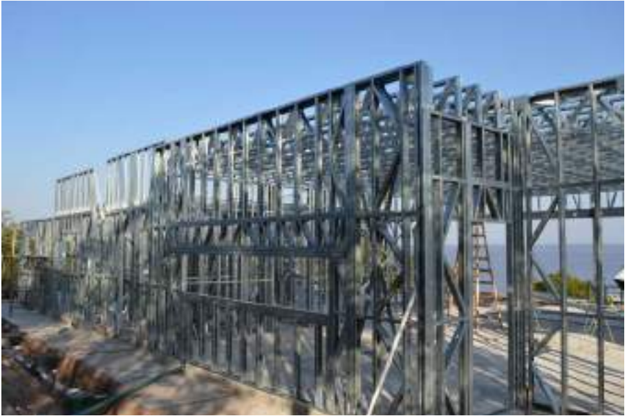
Estructura de casa en STEEL FRAMING. Obra Rio Uruguay 2021.
