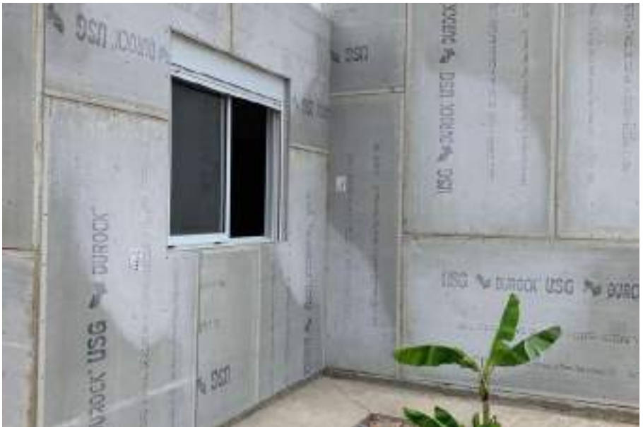
Revestimiento exterior con placa cementicia. Obra Fray Bentos. Año 2020.
