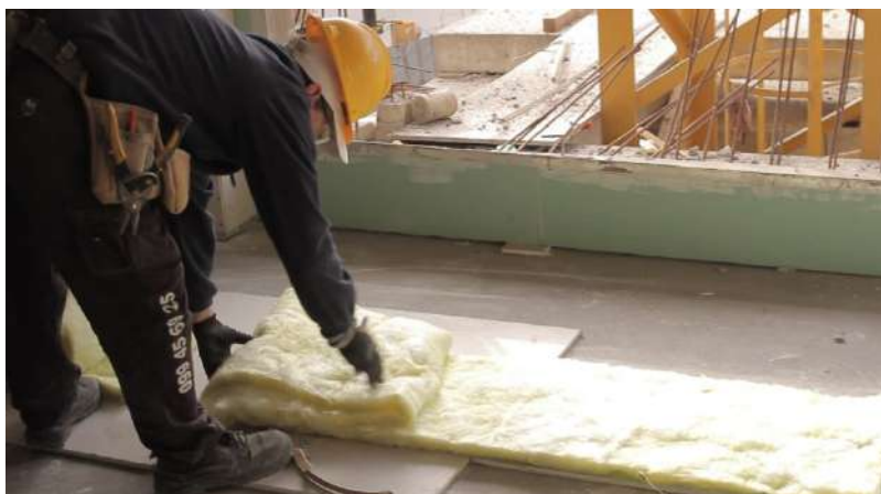
Foto: Operario manipulando la Lana de vidrio con los elementos de protección correspondientes.
