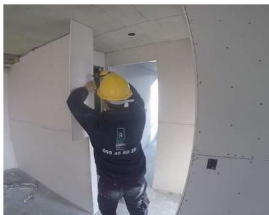
Foto: Colocación de placas de yeso con atornillador eléctrico.
