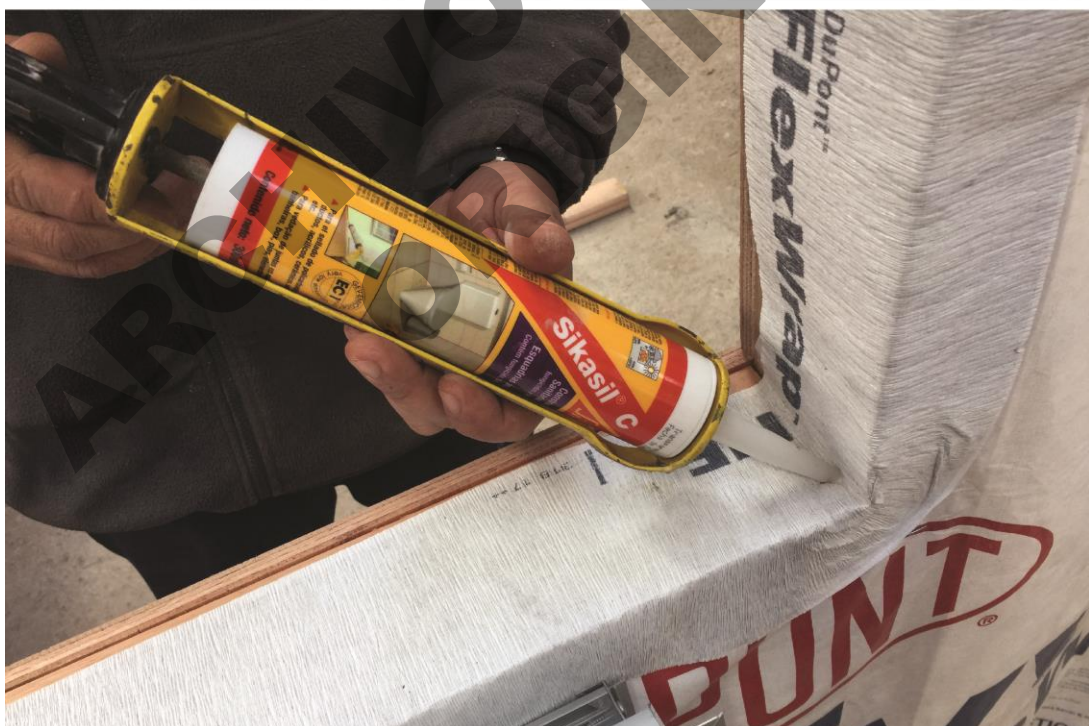
Aplicación de silicona para asentar antepecho de fibrocemento con gotero
