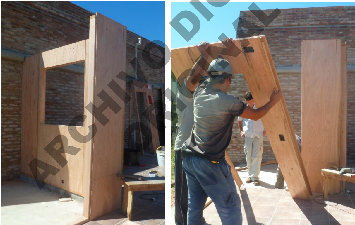
El sistema de machihembrado lateral entre paneles y encastre inferior a la solera, facilita y agiliza el montaje evitando apuntalados provisionarios.
