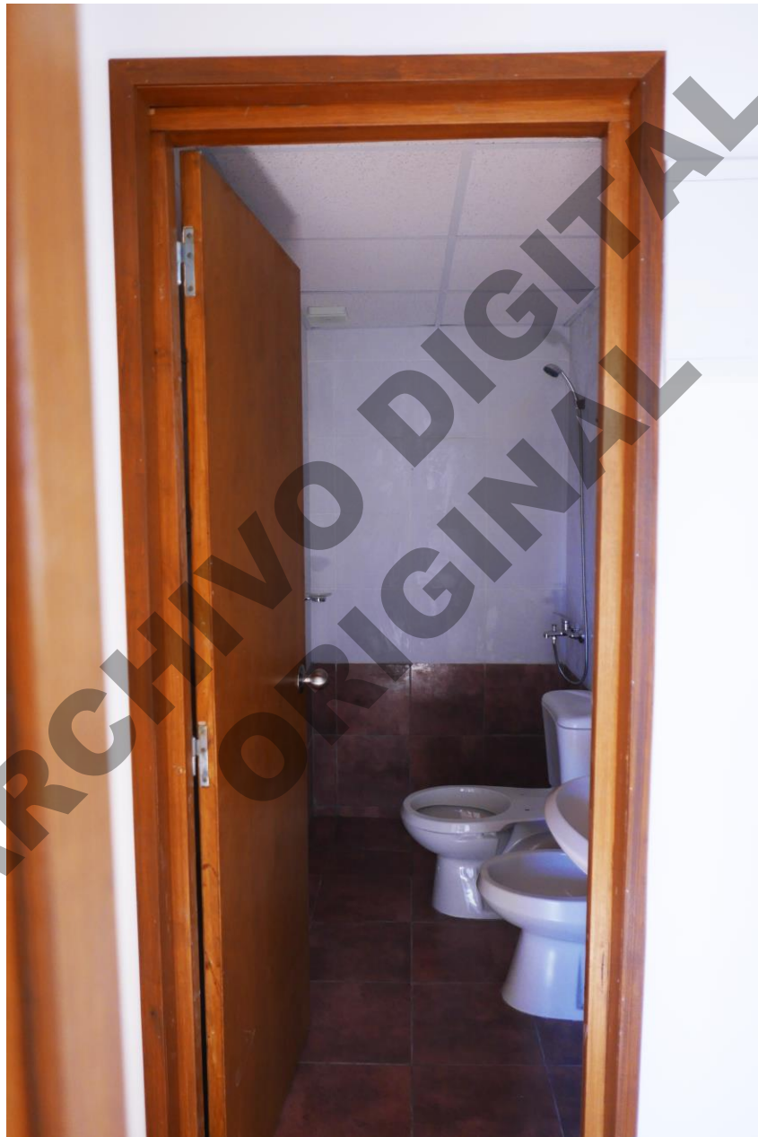
Terminación de puerta interior tipo cajón: contramarco y complemento
