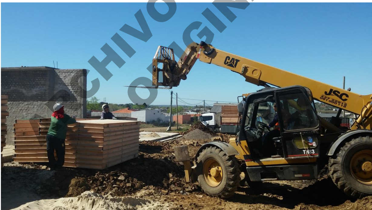
Descarga con manipulador telescópico en la vivienda correspondiente según identificación en paneles
