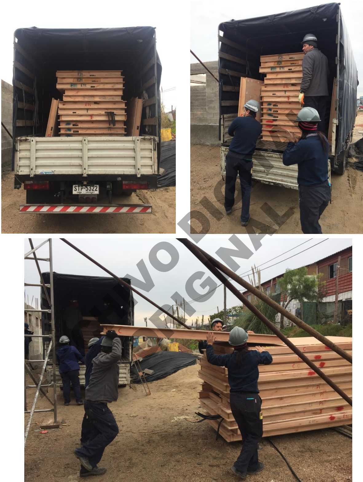
Descarga y transporte manual, según condiciones de la obra
