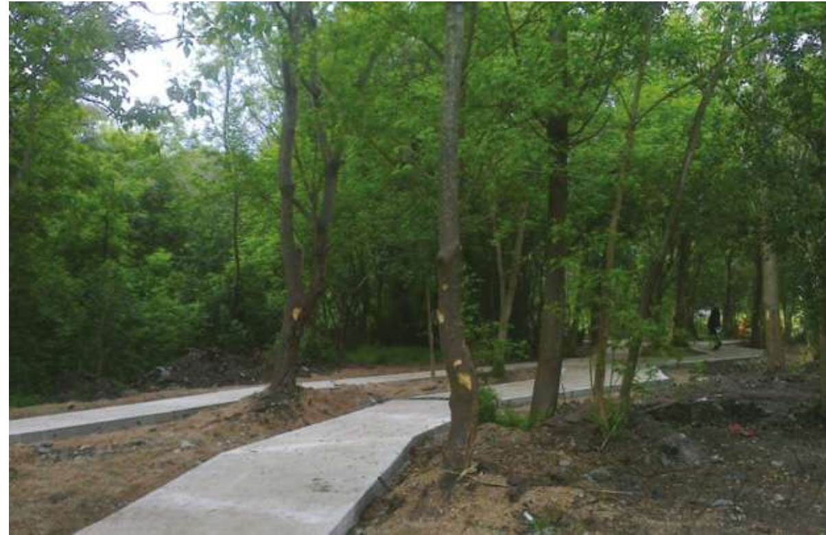
Obra construida: Parque Miguelete, sector Silva-Saravia
