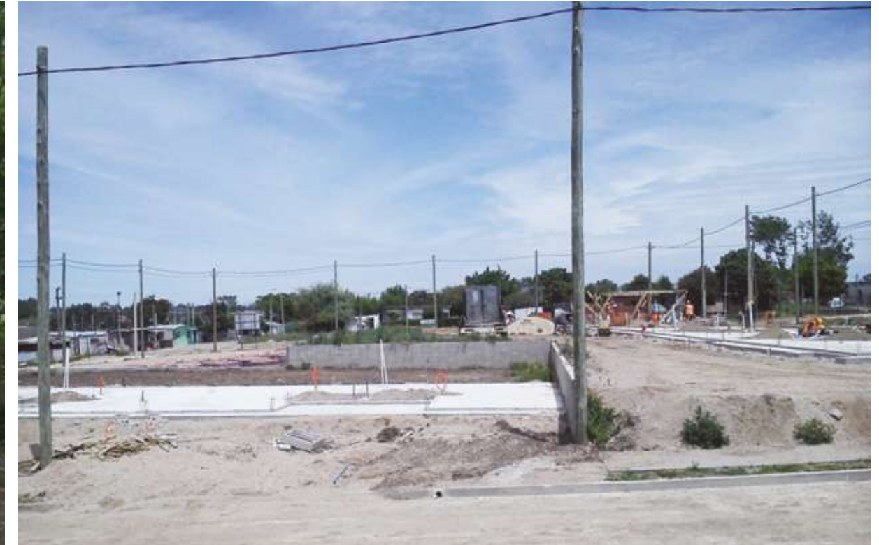
Obra construida: operación urbana Cañada Matilde Pacheco, realojos Antillas y Curitiba
