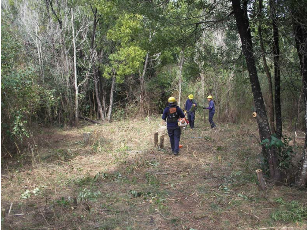
Figura 17. Zona IV en proceso de desmalezado.
