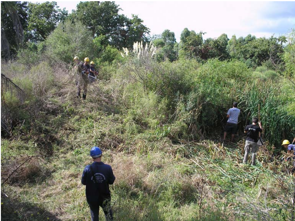
Figura 13. Arriba: Vista de Zona Tajamar desde vía del tren antes de desmalezar. Abajo: Vista de Zona Tajamar durante el proceso de desmalezado.
