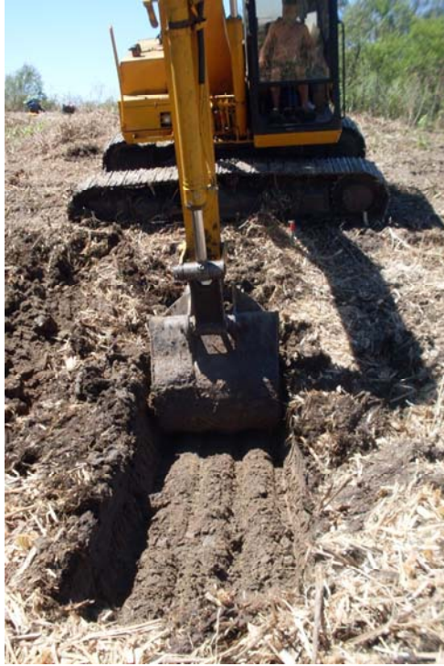
Figura 14. Izquierda: Excavación de trincheras de la Zona Tajamar con retroexcavadora de oruga. Abajo: Vista de Zona Tajamar desmalezada (vista de la vía al frente).
