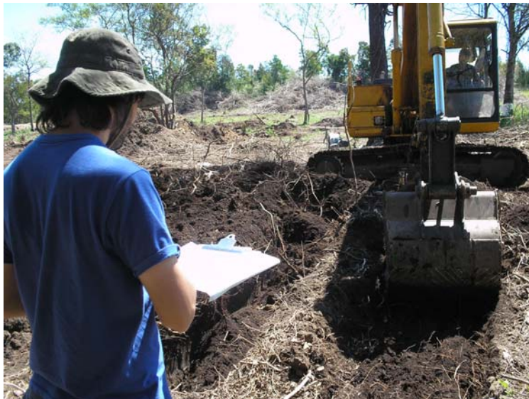
Figura 12. Arriba: Sondeos manuales en Zona III; Abajo: Excavación de trincheras por medio de retroexcavadora con oruga.
