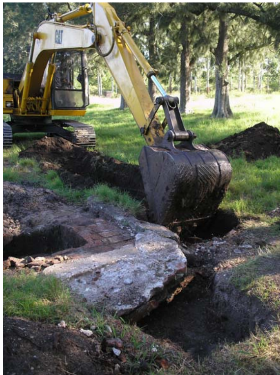
Figura 16. Arriba: Sondeo manual próximo a bloques de cemento en Zona Portón Este. Derecha: Excavación de estructura con retroexcavadora en Zona Portón Este.
